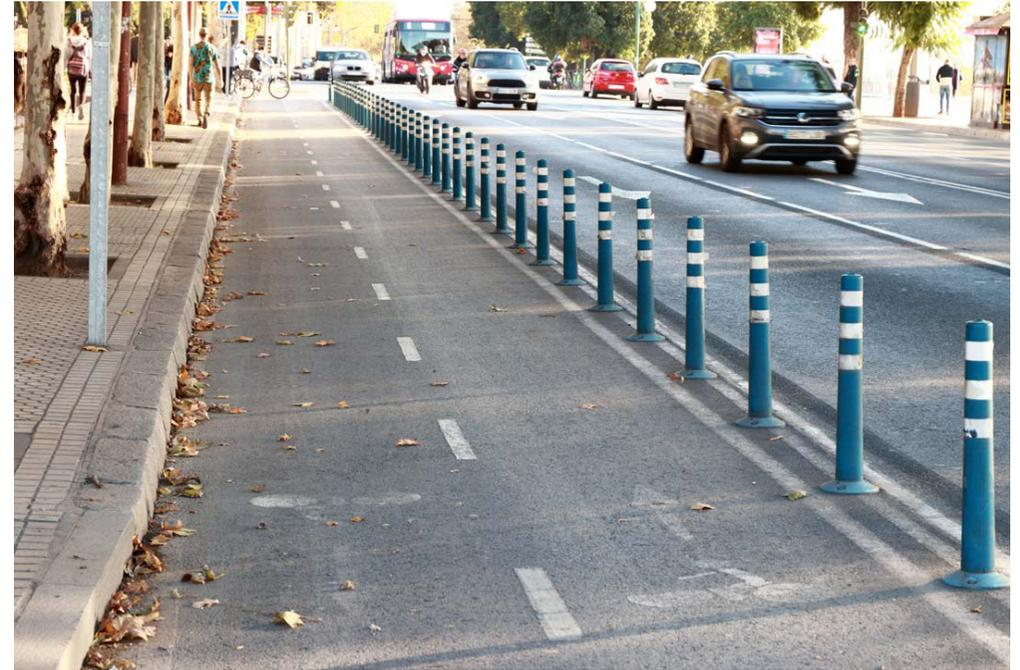
Fotografía 6.46 Hitos cilíndricos como complemento de separadores bajos
