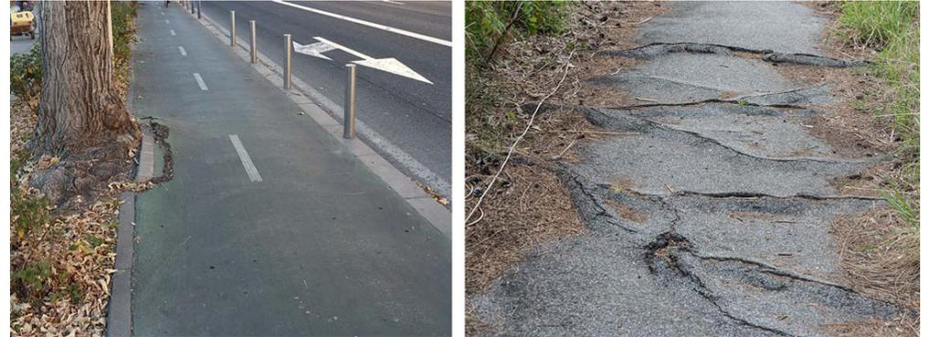
**Fotografía 6.33** Las labores de mantenimiento deben evitar la invasión de vegetación en las vías ciclistas
