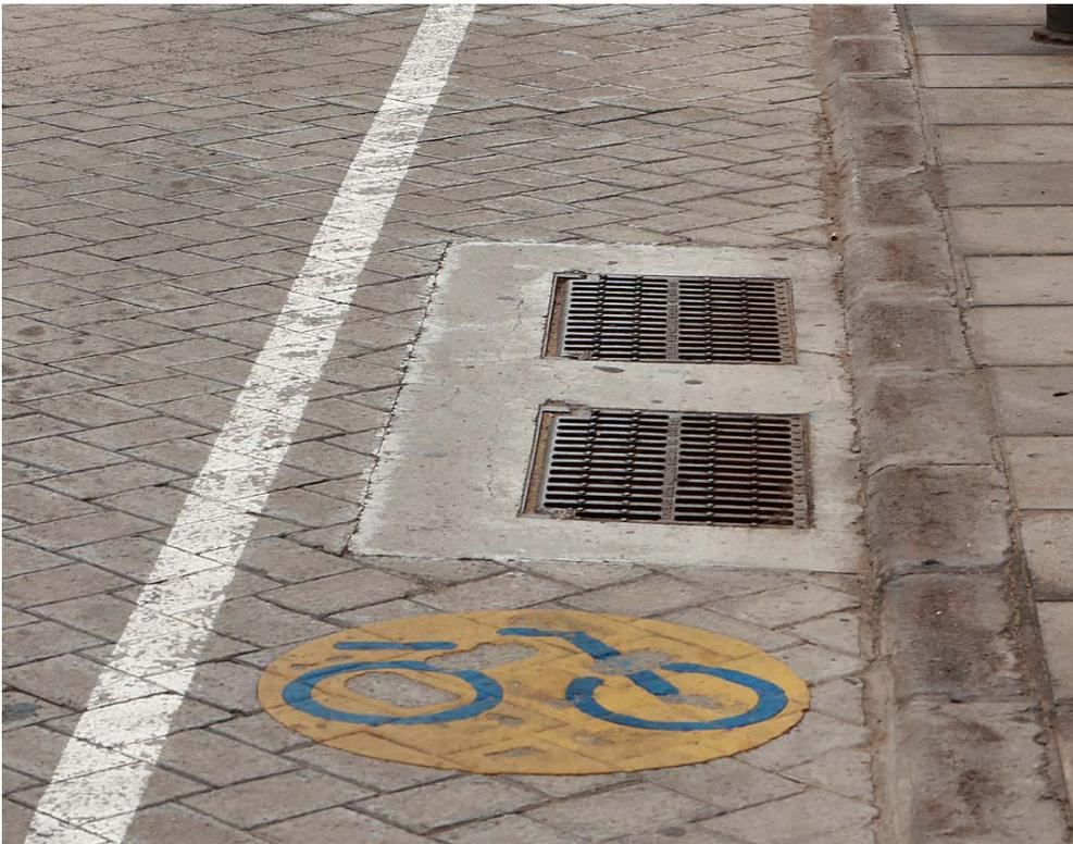
**Fotografía 6.39** Un buen drenaje superficial es fundamental para evitar charcos
