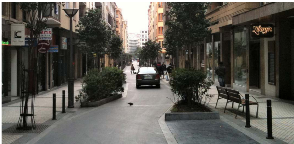
Fotografía 5.36 Zigzag mediante disposición alterna del aparcamiento
