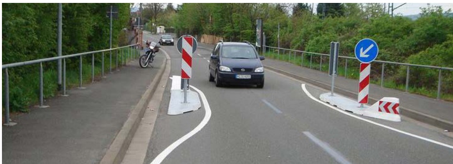
Fotografía 5.34 Estrechamiento lateral en zona interurbana
