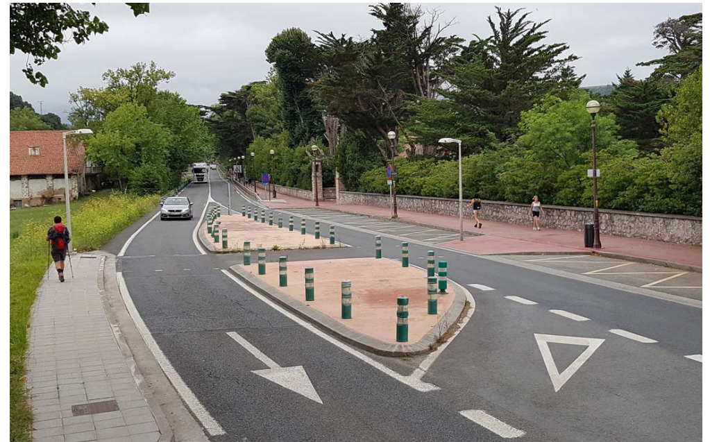
Fotografía 5.40 Cruce peatonal / ciclista sin prioridad sobre carretera
