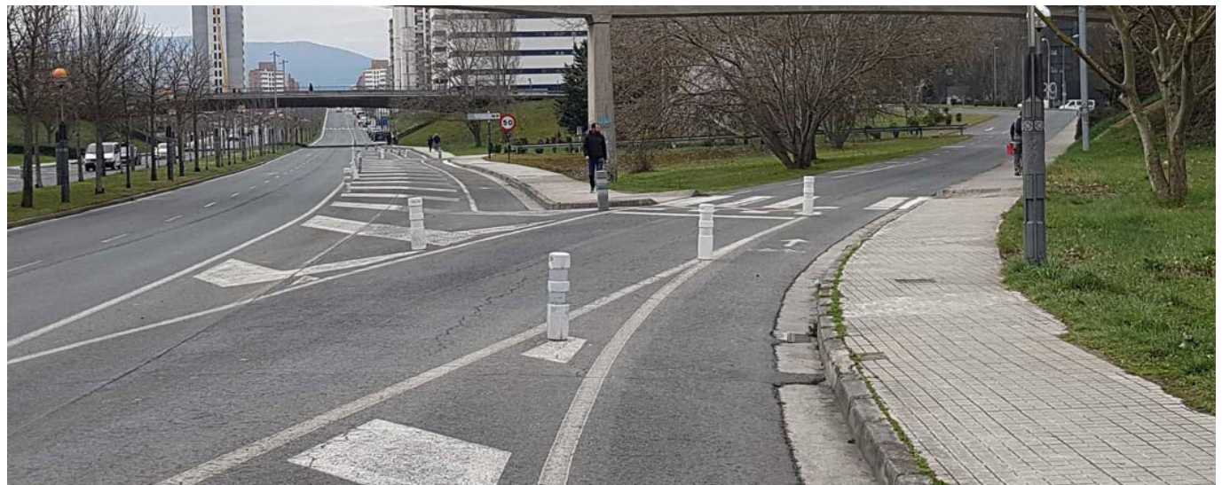
Fotografía 5.16 Paso ciclista unidireccional con retranqueo en vía de deceleración
