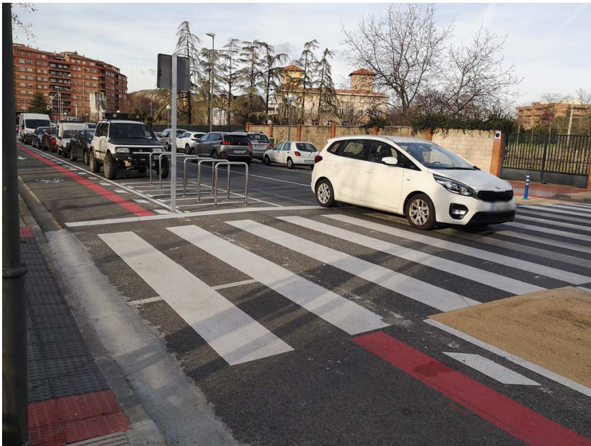
| Fotografía 5.4 Vía ciclista anexa a calzada con paso peatonal único
