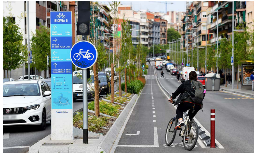
Fotografía 4.16 Vía ciclista bidireccional a la izquierda de la calzada junto a mediana
