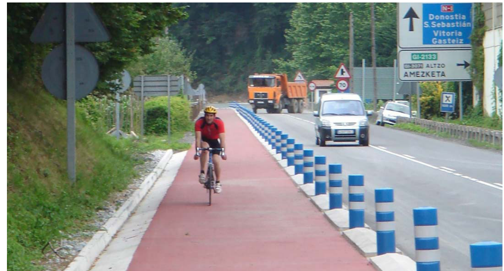
| Fotografía 4.10 Vía ciclista bidireccional protegida en lateral a la derecha en carretera
