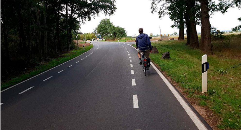
| Fotografía 4.21 Banda de protección en plataforma muy estrecha
