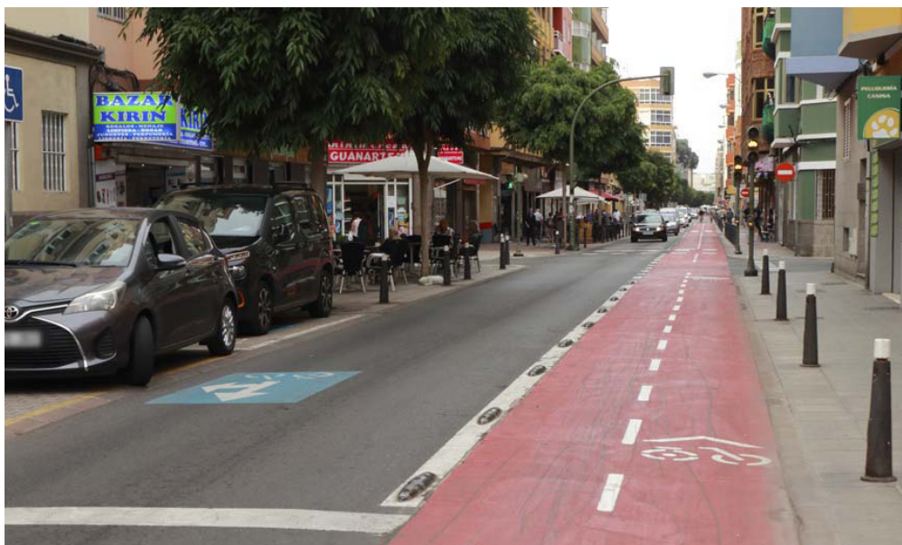
Fotografía 4.15 Vía ciclista bidireccional a la izquierda de la calzada con protección discontinua
