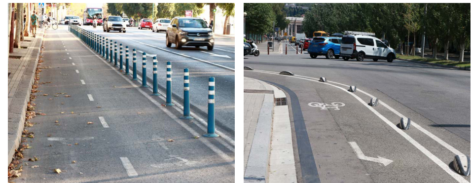
Fotografía 4.4 Elementos de protección discontinua
