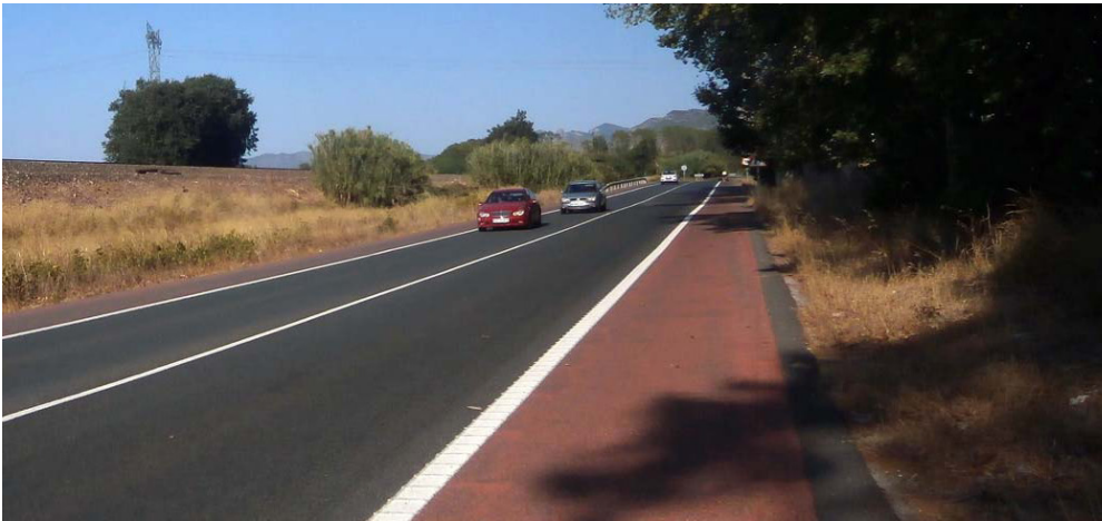
Fotografía 4.24 Acondicionamiento del arcén para la circulación ciclista
