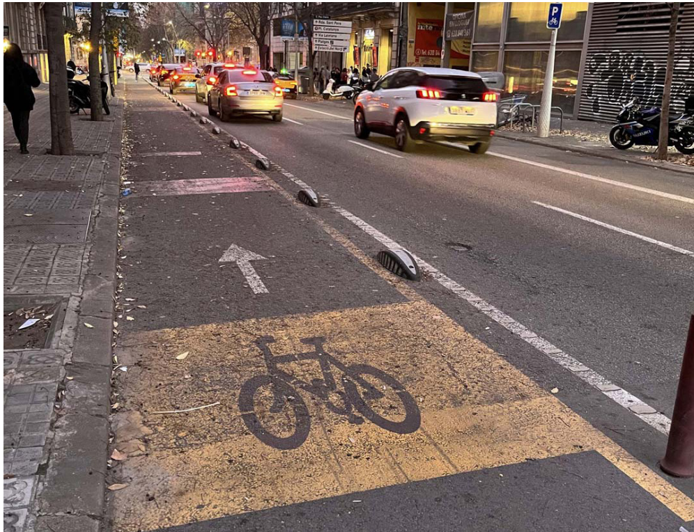
Fotografía 4.14 Vía ciclista unidireccional en el lateral a la izquierda
