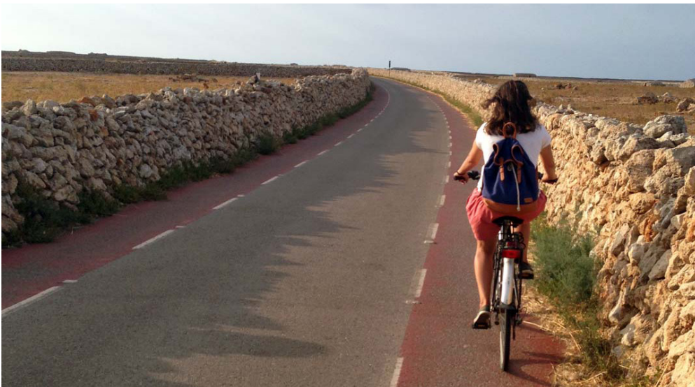
| Fotografía 4.21 Banda de protección en plataforma muy estrecha
