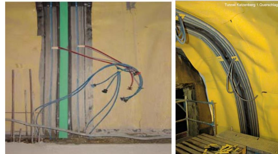
Ejemplos de disposición y soldadura de juntas waterstop.
