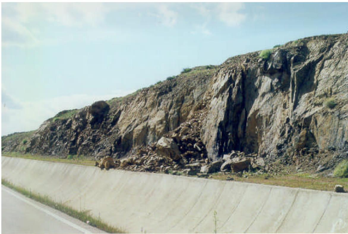
*Foto 13. Talud de alturas pequeñas y pendientes acusadas con abundantes problemas de corrimientos de cuñas. Taludes en las desmontes de los canales, en la margen derecha del embalse de Orellana al oeste de Casas de Don Pedro.*
