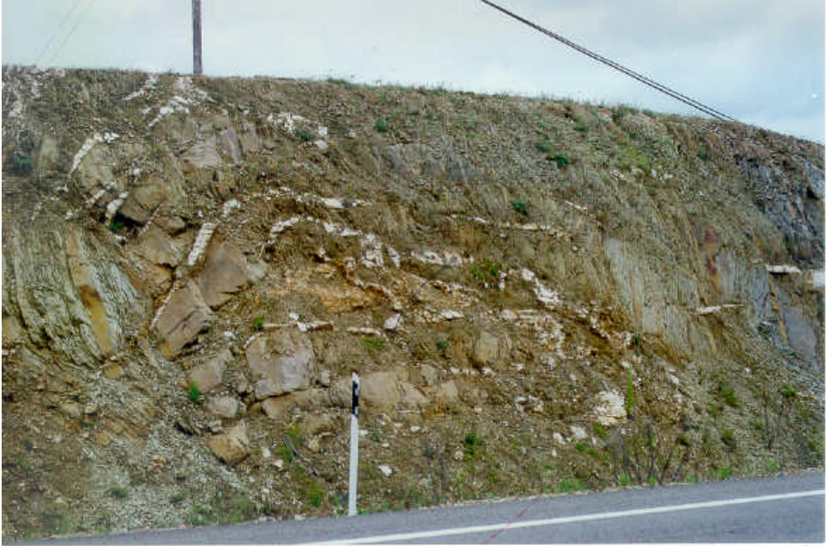
*Foto 12. Diques de cuarzo de la serie esquistograuváquica (grupo litológico (010a)). Talud excavado entre los pk(58) y pk(59) de la carretera C-413.*
