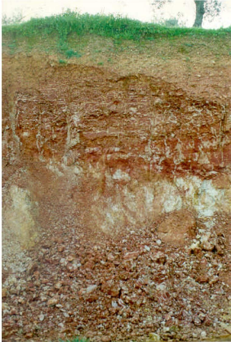
*Foto 8. Pequeño desprendimiento de las pizarras alteradas del grupo (V). En la parte superior de la foto se observa un pequeño nivel coluvial que normalmente tapiza este grupo. Desmonte realizado en la carretera comarcal 413 al Oeste de la Puebla de Alcocer.*
