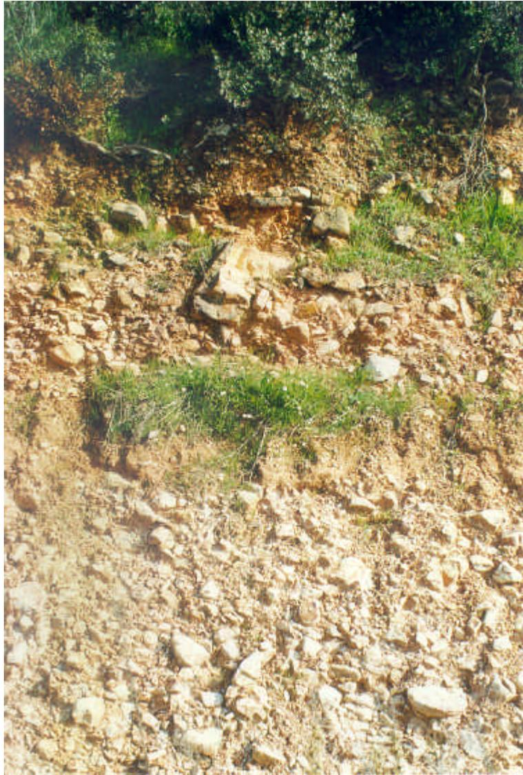
*Foto 36. Conglomerados de cuarcitas pertenecientes al grupo litológico (350). Talud excavado en la raña entre el pk(3) y pk(4) de la carretera que une las poblaciones de Orellana de la Sierra y Navalvillar de Pela.*
