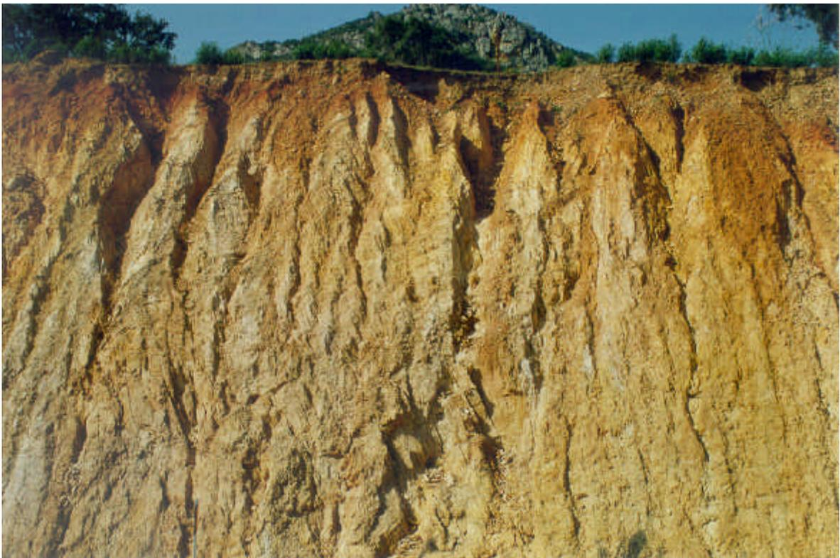
*Foto 7. Problemas de erosión y acarreamiento en los taludes excavados sobre los materiales arcillosos del grupo litológico (V). Pizarras profundamente alteradas en la trinchera, junto a Orellana de la Sierra, en la carretera que une esta población con Navalvillar de Pela.*
