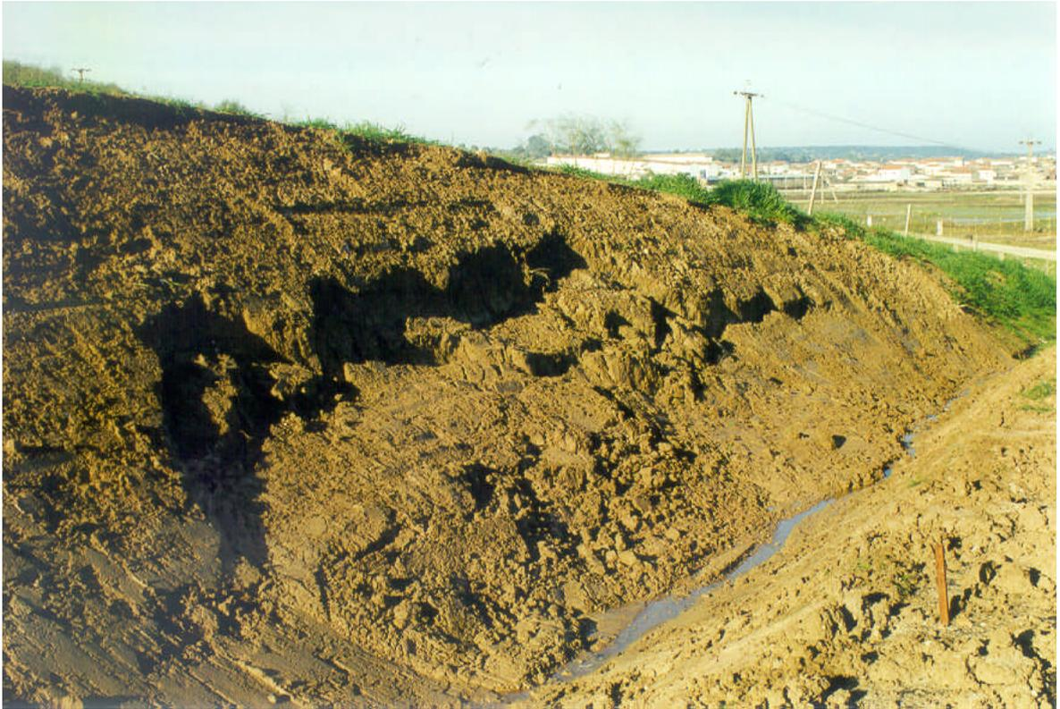
*Foto 40. Deslizamiento de los materiales del grupo litológico (321a) en el talud de la carretera N-430 a la entrada a Madrigalejo. Al fondo, dicha población.*
