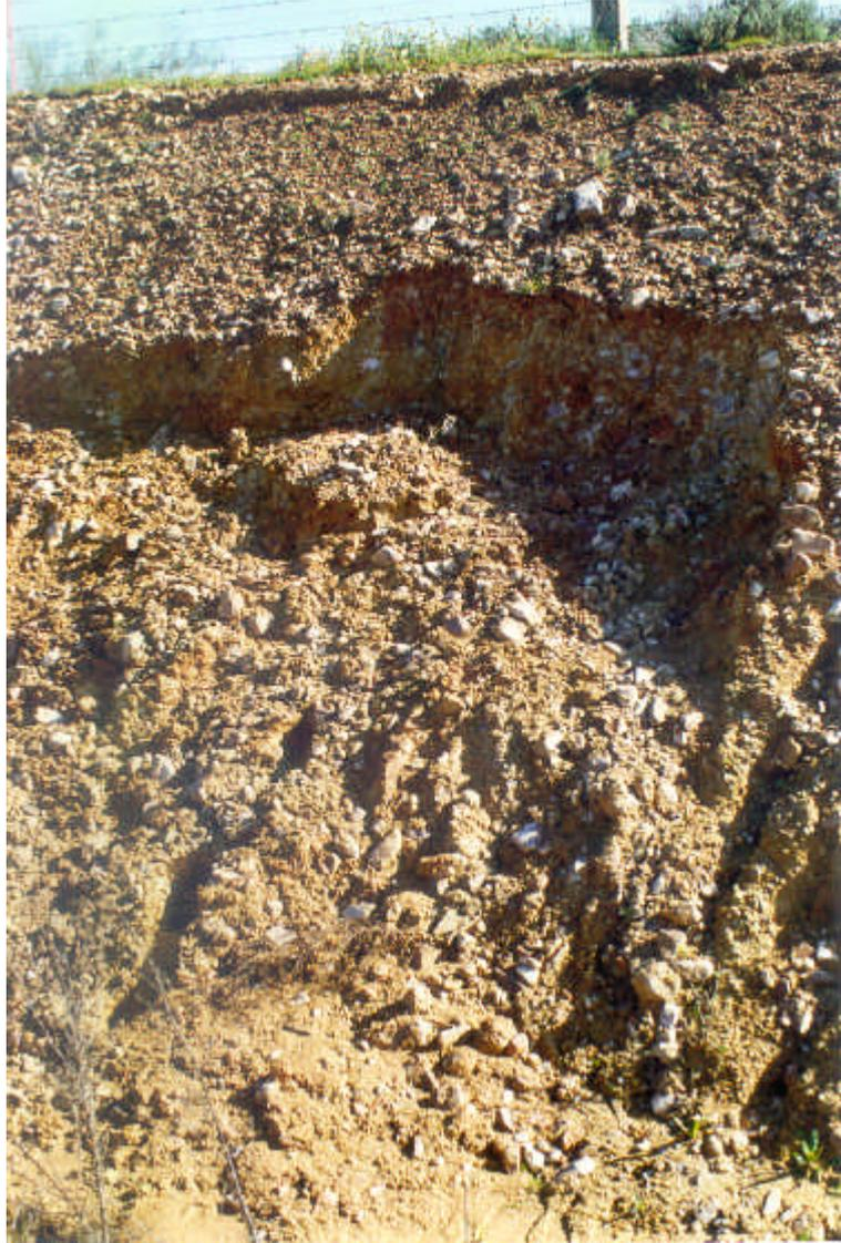
*Foto 35. Conglomerados alterados de cuarcitas pertenecientes al grupo litológico (g). En la foto se puede observar un pequeño deslizamiento a consecuencia del gran contenido en caolín que puede presentar localmente en su composición. Talud sobre la carretera N-430 a la altura de Casas de Don Pedro.*
