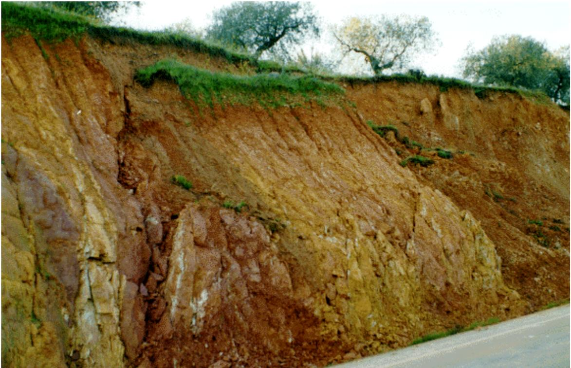
*Foto 9. Deslizamiento rotacional sobre los materiales alterados pertenecientes al grupo litológico (V) en un desmante de la carretera C-413 al oeste de la Puebla de Alcocer.*
