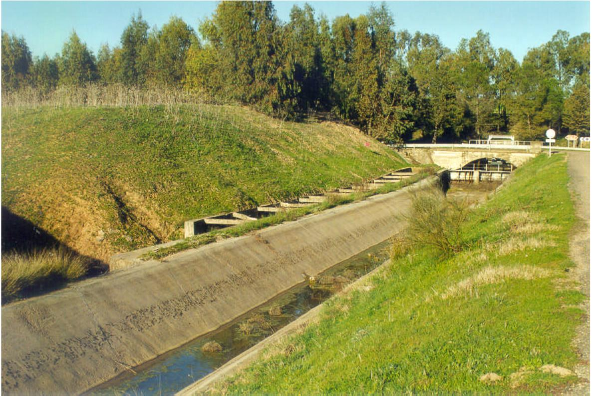
*Foto 39. Estructuras de aguante al pie de los pequeños, pero muy inestables, taludes realizados en la construcción del canal que une Madrigalejo y Zurbarán. Pk(0'5), cercanías al almacén del butano.*
