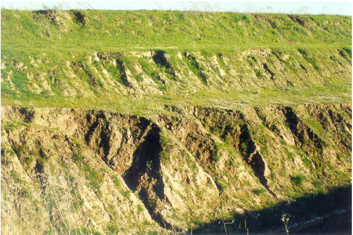
*Foto 38. Pequeño talud realizado en la construcción del canal principal de Madrigalejo en el que se observan importantes problemas de erosión en las bermas.*
