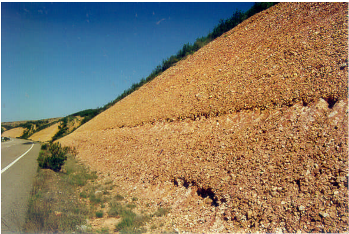
Foto nº 47. Grandes desmontes de hasta 15 m de altura en la formación pliocena que integra el grupo litológico 322. Talud 1H:1V con un buen comportamiento. P.K. 212+100 de la carretera N-430.
