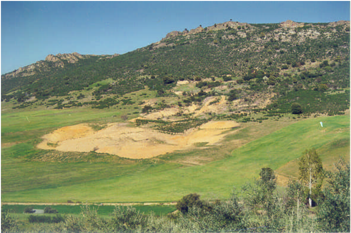
Foto nº 4. Deslizamiento activo que afecta los coluviales y manto de alteración del grupo litológico 010a, y que se superpone a otras estructuras fósiles de mayor envergadura prácticamente desdibujadas. Fuente del tío Marcelo, en las cercanías de Arroba de los Montes.
