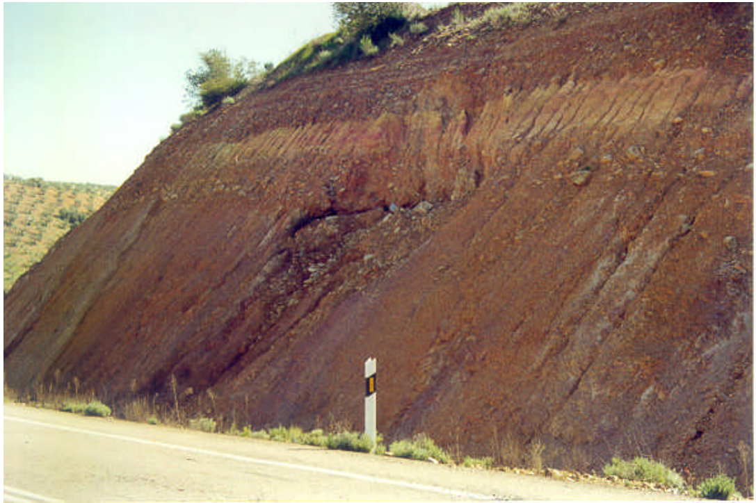
Foto nº 45. Deslizamiento de tierras en un talud por efecto de las aguas que circulan a media altura, por el contacto de la unidad pliocena suprayacente (grupo litológico 322) con el manto de alteración impermeable del substrato pizarroso, que constituye el grupo litológico 122a. P.K. 227+000 de la carretera N-430.
