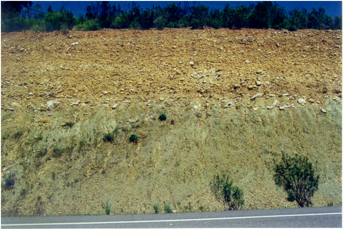
Foto nº 44. Desmonte donde aflora el grupo litológico 322 sobre las pelitas muy alteradas del Precámbrico (grupo litológico 010a). P.K. 209+000 de la carretera N-430.
