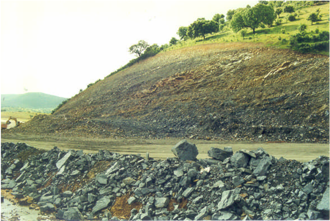
Foto nº 18. Alternancia de pizarras ampelíticas, areniscas micáceas y cuarcitas (grupo litológico 122d) en un desmonte de reciente construcción en la carretera que une la N-430 con Agudo (variante de la N-502). Próximo al P.K. 203+000 de la CN-430.
