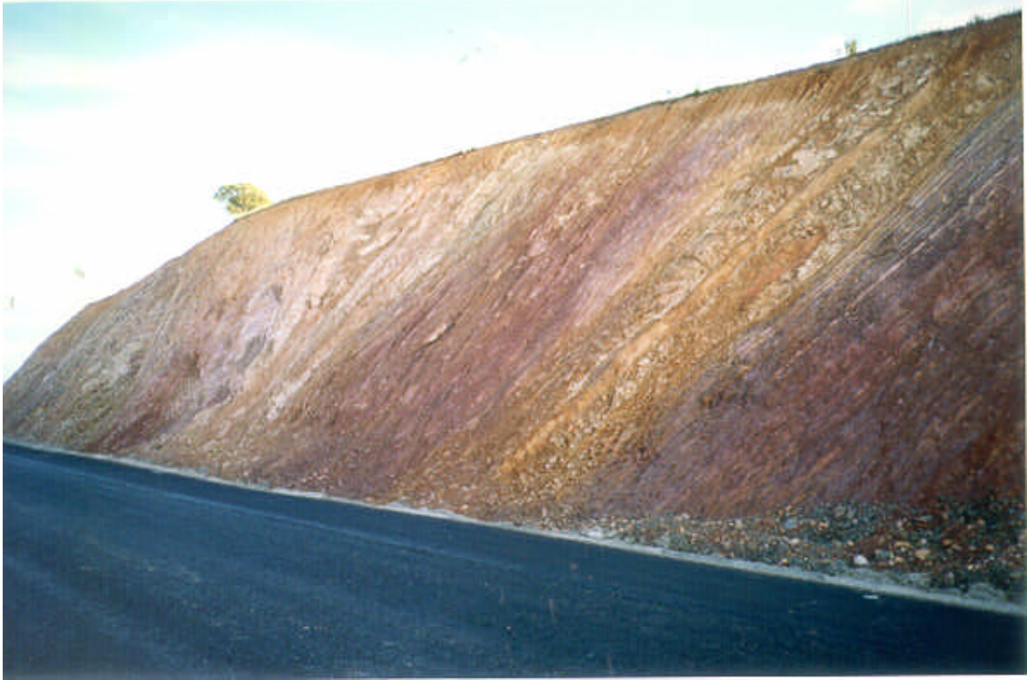
Foto n° 33. Alternancias de cuarcitas y pizarras del nivel superior del grupo litológico 120b. Variante de reciente construcción de la carretera N-502, Valle de Santa María.
