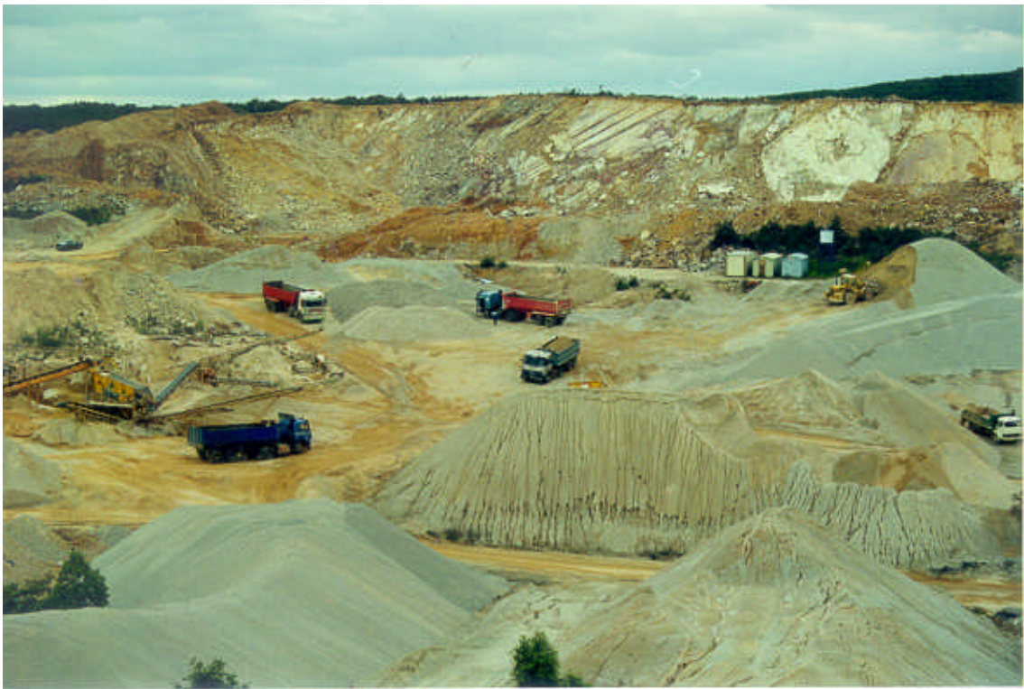
Foto nº 55. Cantera en las cuarcitas del grupo litológico 131 (YR-1). P.K. 13+000 de la carretera comarcal 503, de Fuenlabrada de Montes al Puerto de los Carneros.
