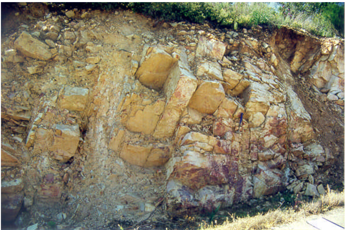
Foto nº 30. Individualización y caída de bloques por la combinación desfavorable de diaclasas y planos de estratificación en un talud practicado en la Cuarcita Armórica (grupo 121b), donde se observan capas con importantes alteraciones caoliníferas. Puerto de Riofrío.
