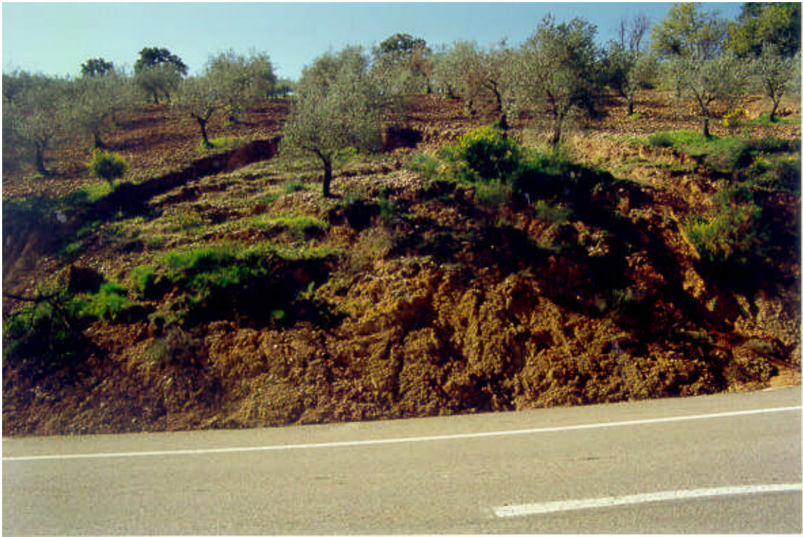
Foto nº 53. Deslizamiento circular del recubrimiento coluvial que conforma los derrames de la raña que se extiende por encima, a favor del contacto con el manto de alteración del substrato pizarroso que conforma el grupo litológico 122a. Talud situado en el P.K. 228+000 de la carretera nacional 430.
