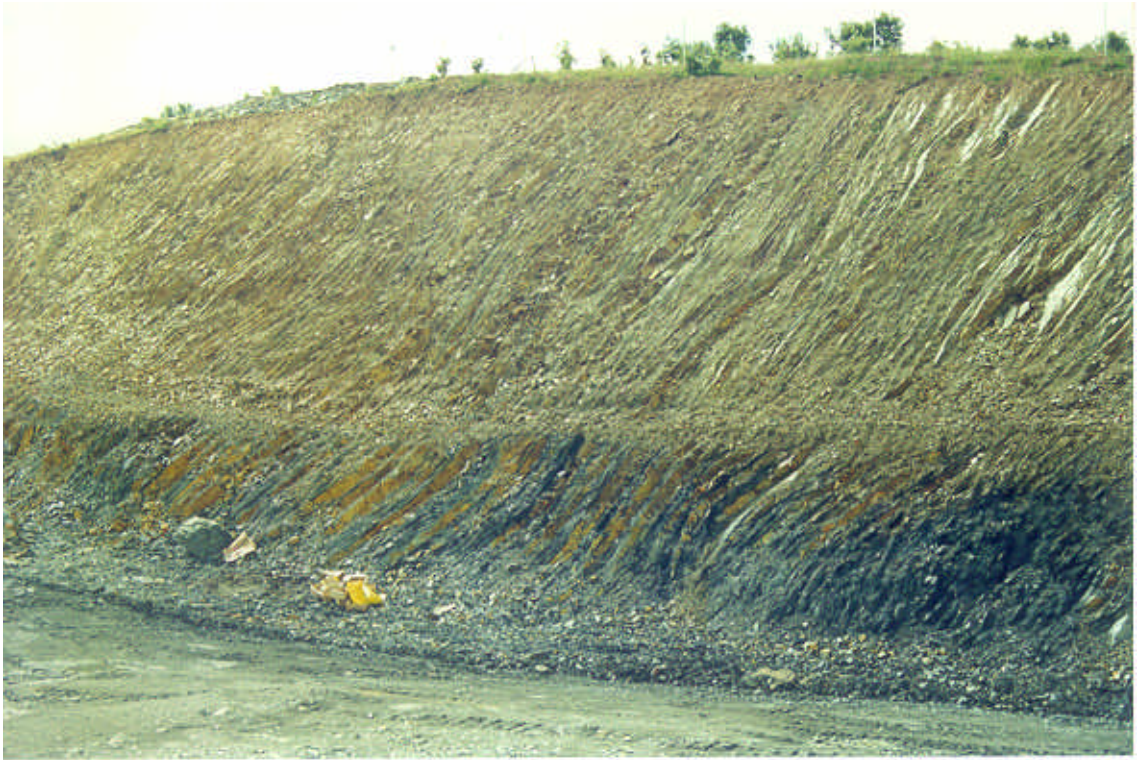
Foto nº 20. Desmonte practicado en las pizarras y areniscas del grupo litológico 122c en la variante a la carretera N-502. Próximo al P.K. 202+000 de la carretera N-430.
