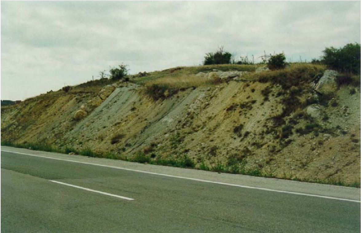
FOTO N° 49. Desmonte situado en el P.K. 114+500 de la N-611. En el talud afloran alternancias decimétricas a métricas de arcillas, lutitas, areniscas y niveles de calizas, pertenecientes al tramo detrítico/carbonatado de la F. Purbeck (grupo 230c).
