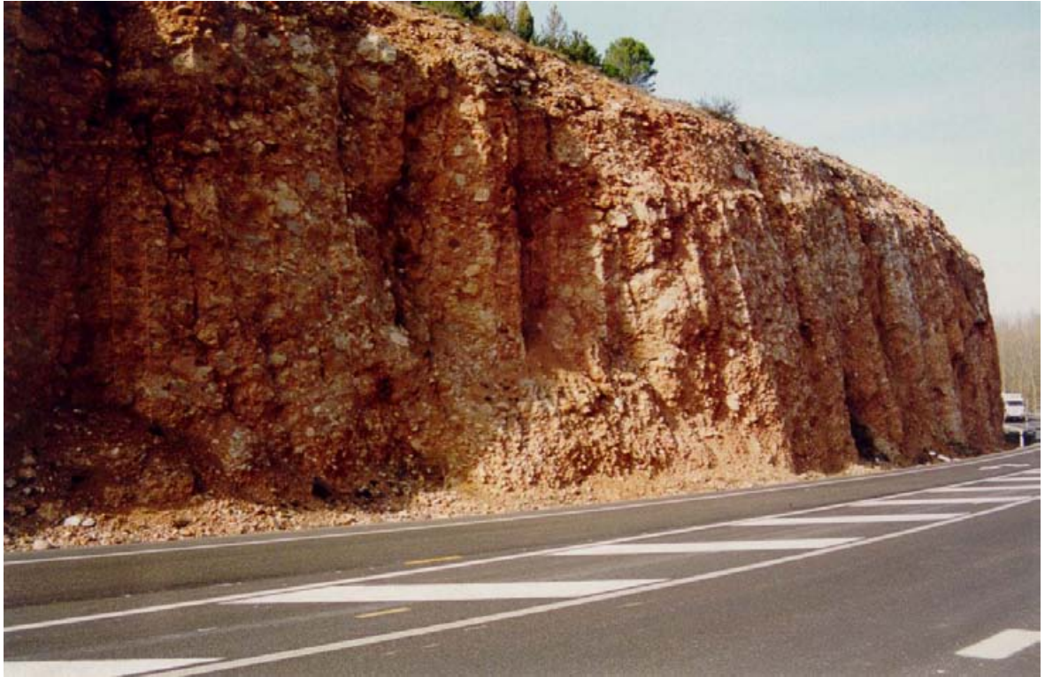
FOTO N° 25. P.K. 93+000 de la carretera N-611. Desmonte practicado mediante voladuras, en la formación de conglomerados calcáreos del grupo 300c, fuertemente cementados. En el talud se observan planos de fractura y conductos kársticos, que individualizan bloques que pueden verse inestabilizados.
