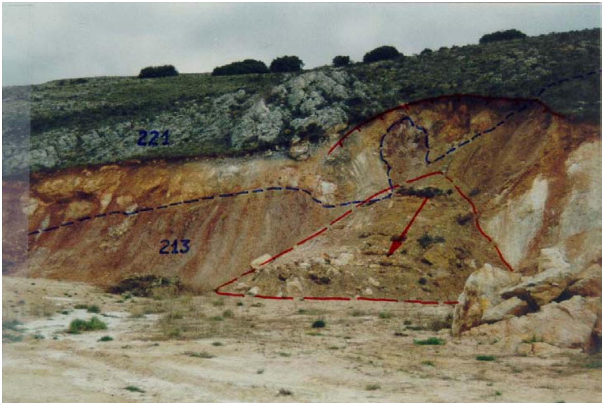
FOTO N° 55. Contacto de los limos y arcillas del Triásico Superior (Grupo 213) con las calizas y dolomías del Jurásico Inferior (Grupo 221), en una zona donde han sido extraídos áridos del coluvial que recorre el pie de la ladera, para la construcción de caminos rurales. Próximo a la localidad de Pozancos.
