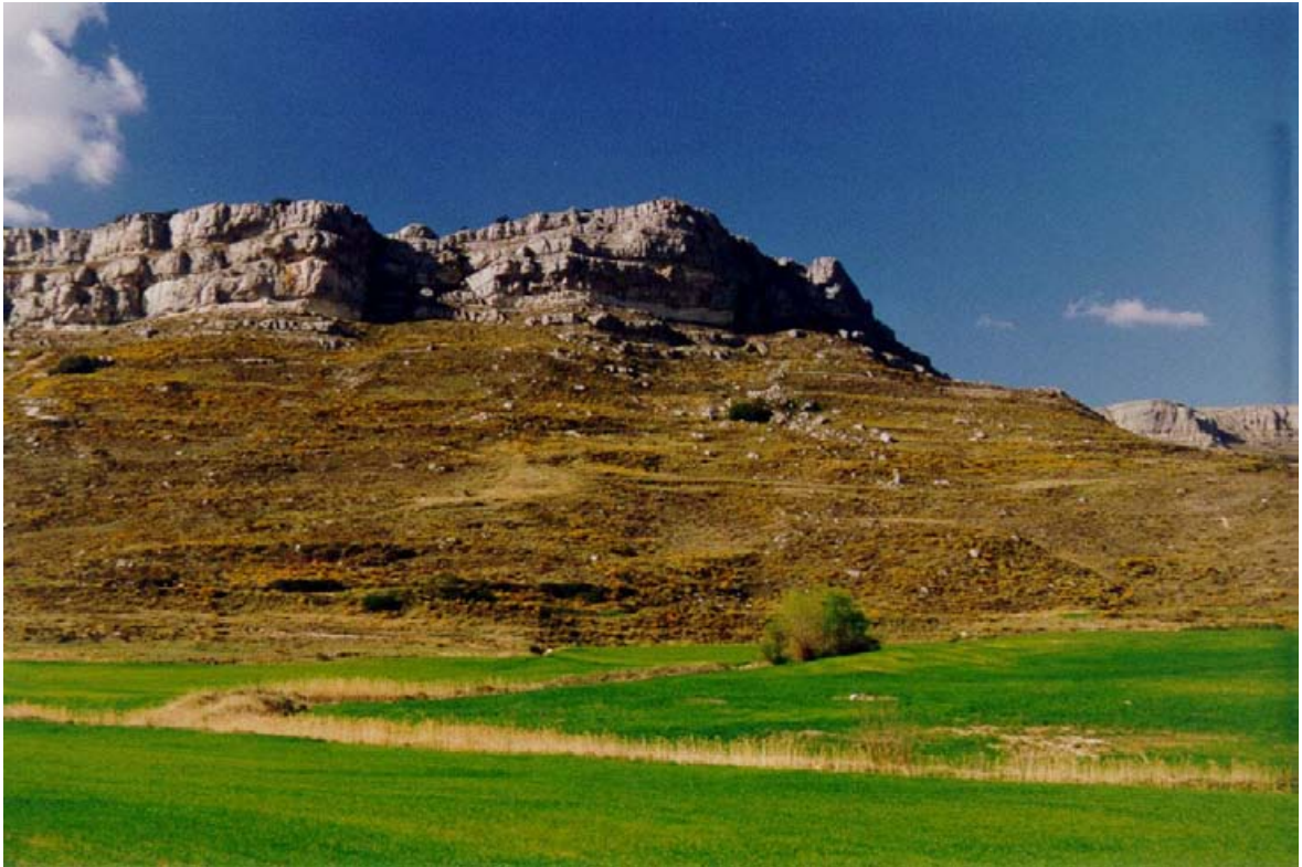
FOTO N° 29. Ladera afectada por importantes procesos de inestabilidad, relacionados con desprendimientos de bloques calizos del escarpe rocoso, integrado por el grupo 232c, y deslizamiento de los materiales arenosos del grupo 230b que conforman el tramo inferior de la ladera. Valle del arroyo de los Tovares, al N del pueblo abandonado de Puentes de Amaya.
