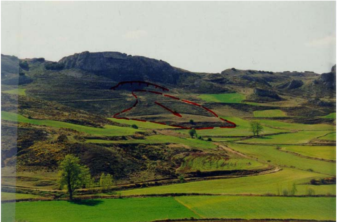
FOTO N° 30. Gran deslizamiento fósil en una ladera del valle del arroyo de los Tovares, cercano a la localidad de Salazar de Amaya. El deslizamiento afecta a los materiales arenosos del grupo 230b.
