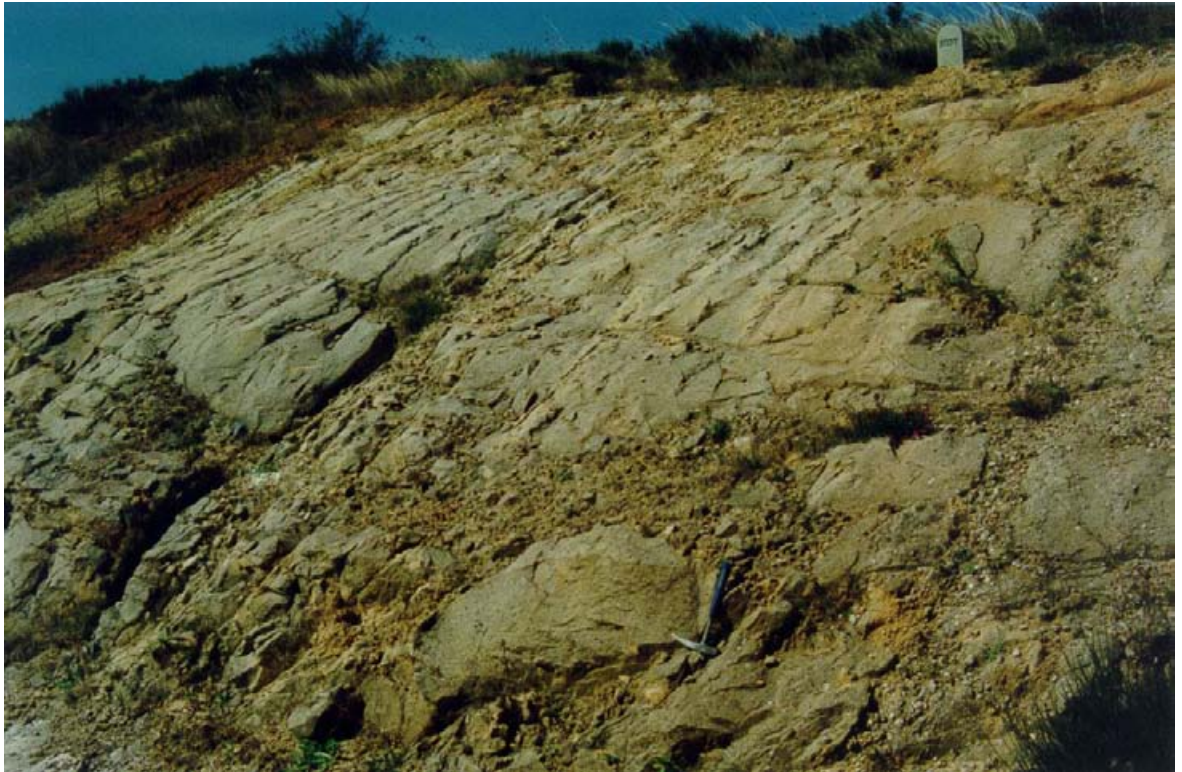
FOTO N° 40. Desmonte situado en el P.K. 113+100 de la N-611, donde afloran niveles, de espesor métrico, de areniscas y conglomerados de la F. Purbeck, fuertemente cementados; pertenecientes al grupo 231a.
