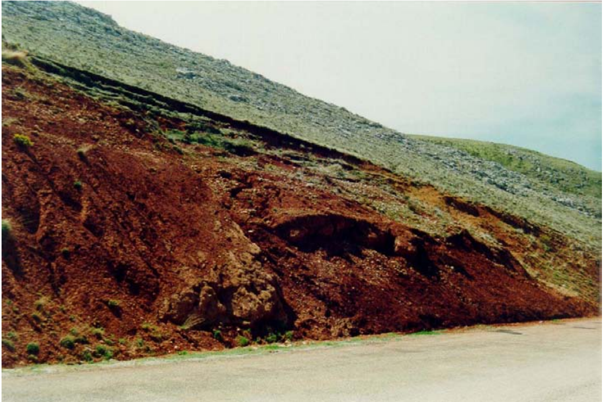
FOTO N° 26. Deslizamiento del talud situado en la carretera local de Villamartín de Villadiego a Amaya. En este punto afloran arcillas y conglomerados del grupo 300c.
