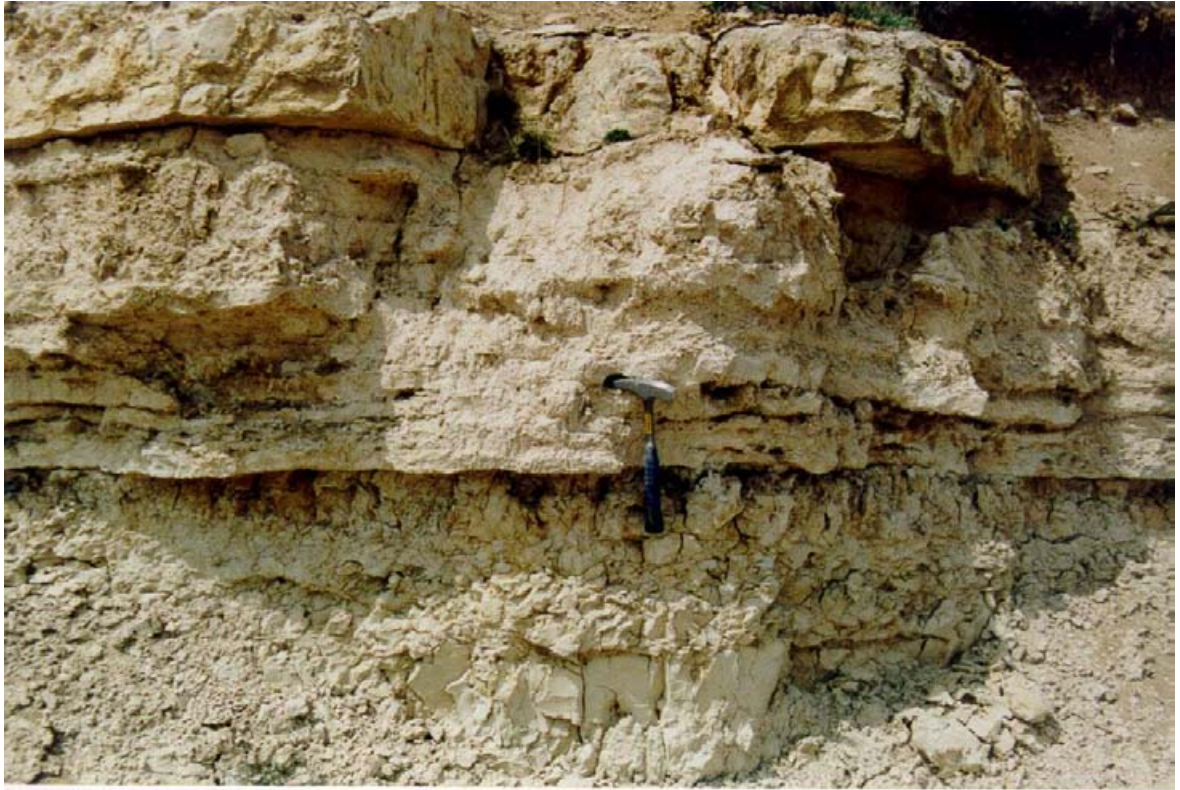
FOTO N° 4. Aspecto que presentan los materiales del grupo 321c, que corresponde a una alternancia de calizas oquerosas más o menos margosas, margas y arcillas higroscópicas.
