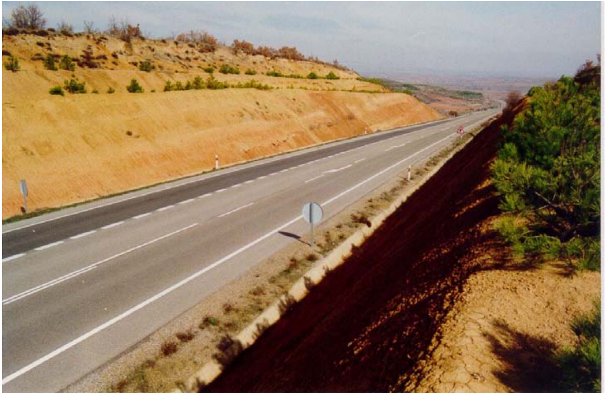
FOTO N° 19. Desmorte en los fangos de la Facies Grijalba-Villadiego (Grupo 300a) situado en el P.K. 72+000 de la carretera N-611. Los taludes alcanzan alturas de hasta 15 m y pendientes de 45°.
