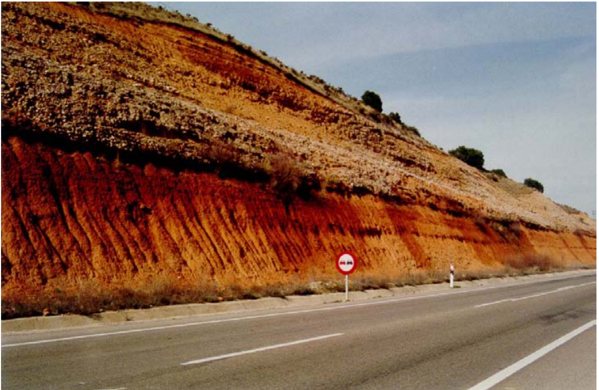
FOTO Nº 12. P.K. 89+000 de la carretera N-611. En el talud afloran los conglomerados del grupo 321a sobre los fangos del grupo 300a. Existe un acuífero colgado cuyas aguas fluyen por el contacto entre ambas formaciones.
