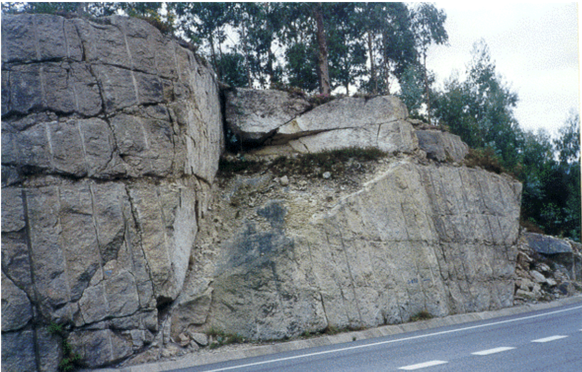
Foto 3.37. Cuña deslizada en talud practicado en el grupo litológico (001a)
