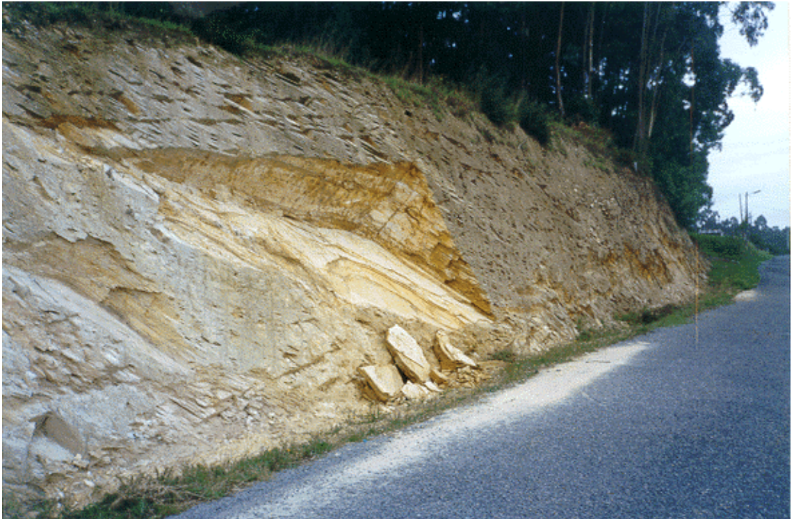
Foto 3.35. Cuña deslizada en talud practicado en el grupo litológico (111b)
