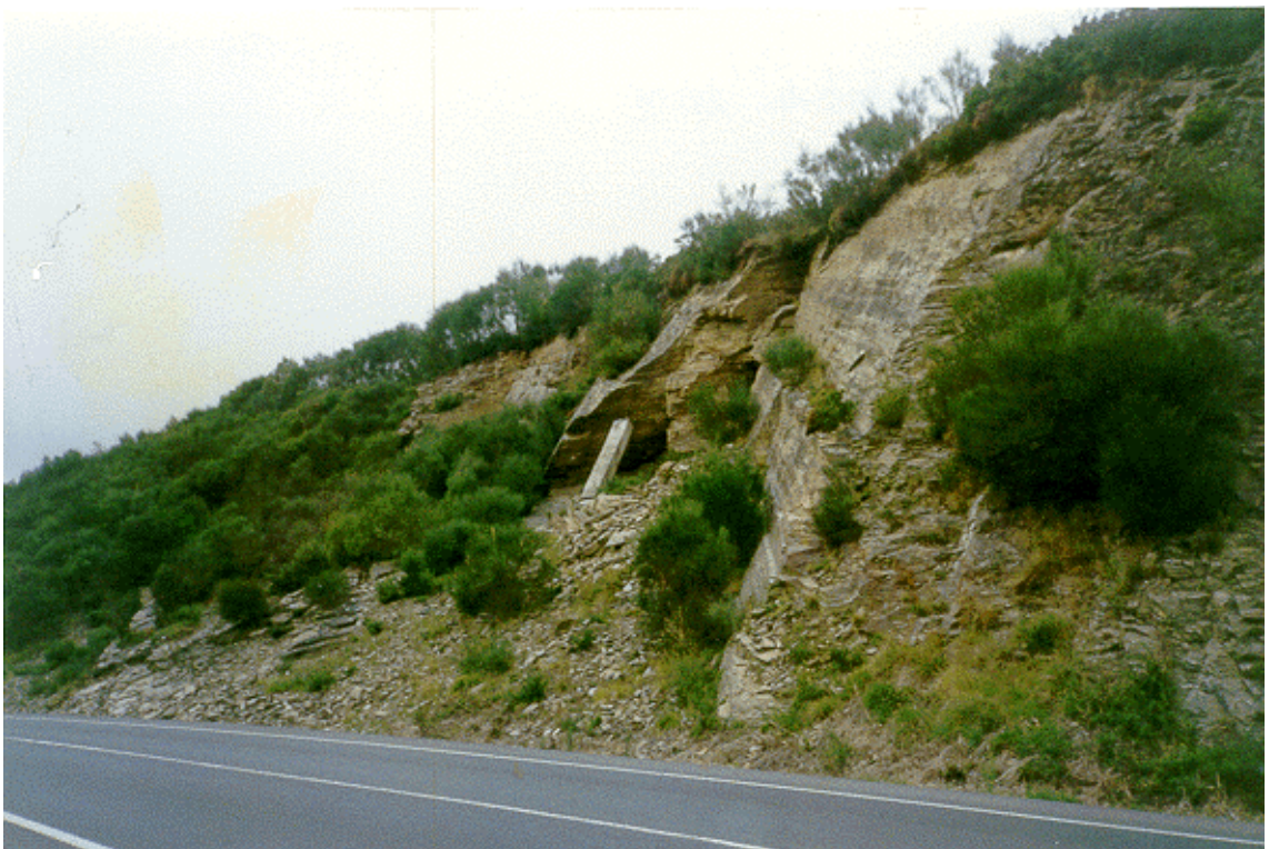
Foto 3.35. Cuña deslizada en talud practicado en el grupo litológico (111b)
