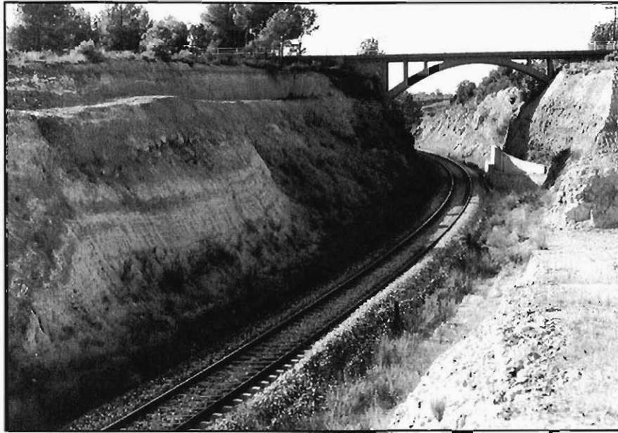
Foto 31.- Facies brechoides y conglomeráticas junto a facies margosas, grupo (321b). El conjunto se encuentra plegado e intensamente fracturado. Trincher del FFCC en las proximidades de Algar de Palancia.
