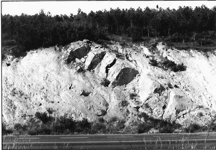
Foto 13.- Tramo de margas, cartografiadas como grupo litológico (223a), incluidas dentro del grupo (223c). En el centro se puede observar un nivel de calizas incluidas en las margas. En este nivel competente, se configura una morfología quebrada por el desalajo de cuñas de roca.
