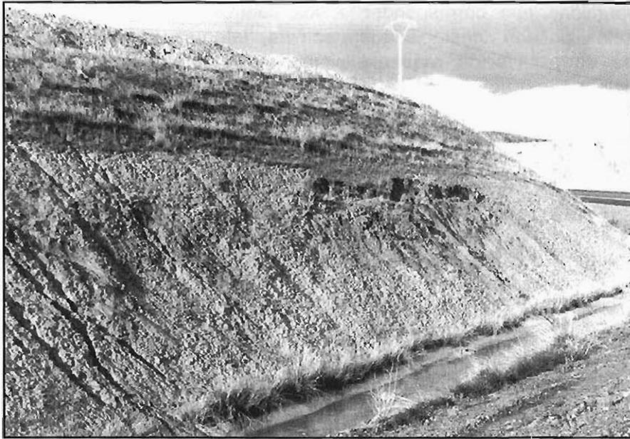
Foto 30.- Talud excavado en arcillas, limos y arenas pertenecientes al grupo geotécnico G7. Al pie del talud se puede observar un pequeño deslizamiento. Cercanías de la población de Palencia.
