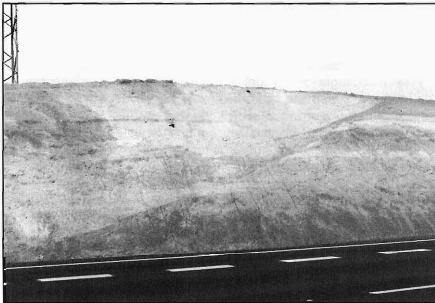
Foto 31.- Talud excavado recientemente en una gran estructura fósil de rotura gravitacional. (Grupo geotécnico G9). Los materiales margosos que lo conforman presentan una inestabilidad superficial por alteración, erosión y pequeñas "escamas" de deslizamiento. Proximidades de San Cebrián de Buena Madre.
