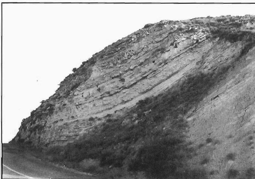
Foto 12.- Suave pliegue observado en un talud construido en las calizas del páramo (grupo litológico 321c), y la serie margo-yesífera inferior (grupo 321d). Carretera de Hornillos de Cerrato a Baltanás.
