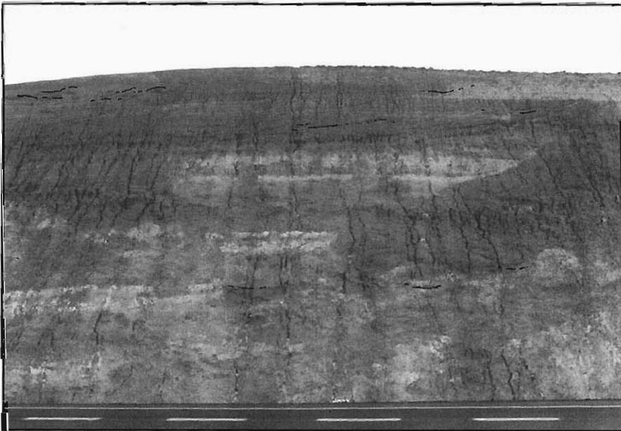
Foto 29.- Otro aspecto de las grandes masas deslizadas en la estructura fósil de la Foto 23. En el talud de reciente construcción se puede apreciar un deterioro rápido por erosión, y la formación de "escamas" de deslizamiento superficial sobre el área alterada. Proximidades a San Cebrián de Buena Madre.
