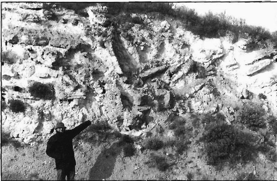
Foto 17.- Rotura gravitacional en el borde de la superficie del páramo. P.K. 50 de la carretera de Hornillos de Cerrato a Baltanás.
