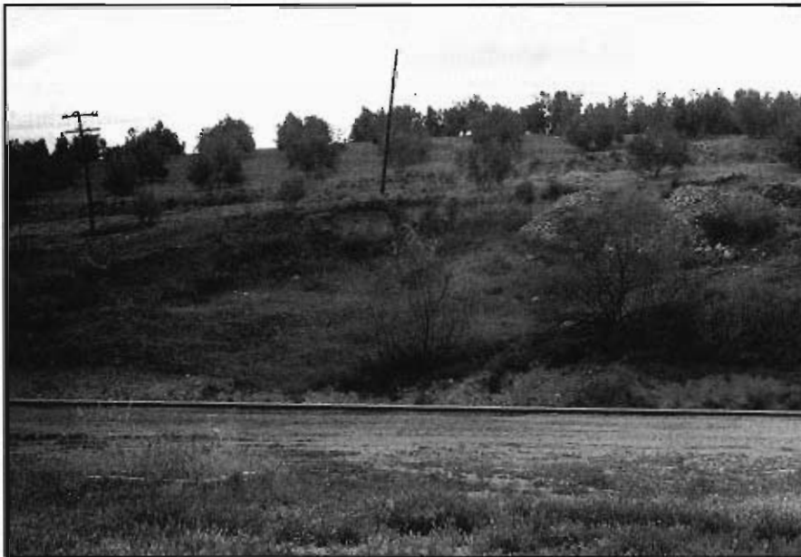
Foto 4.- Deslizamientos originados sobre los materiales del grupo 321c, en la Carretera Nacional Bailén-Motril al Norte de Las Infantas.
