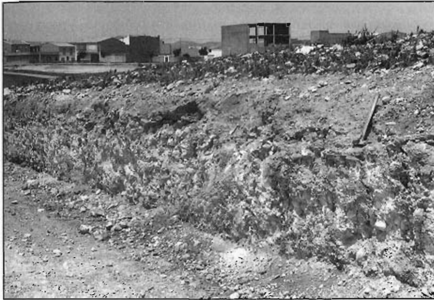
Foto 12.- Talud artificial bajo, cortado en los materiales de este grupo, en la población Villagordo. Se pueden observar las zonas más superficiales con desarrollo de costras calcáreas.
