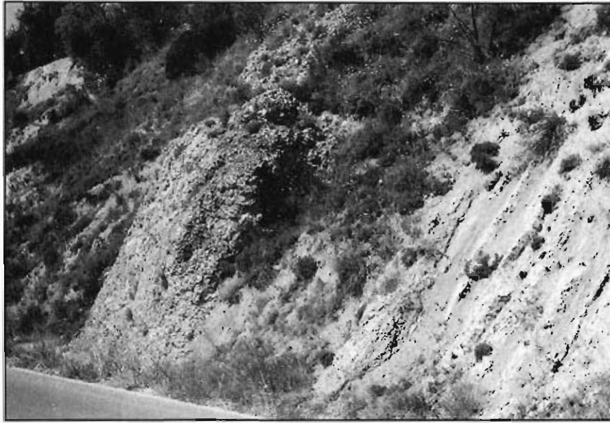
Foto 38.-Talud artificial excavado en los materiales de este grupo en la antigua carretera CN-323 a 2 km al Sur de Campillo de Arenas. En la foto se pueden observar los episodios de brechas (Izq) y los episodios margocalizos (Dcha).
