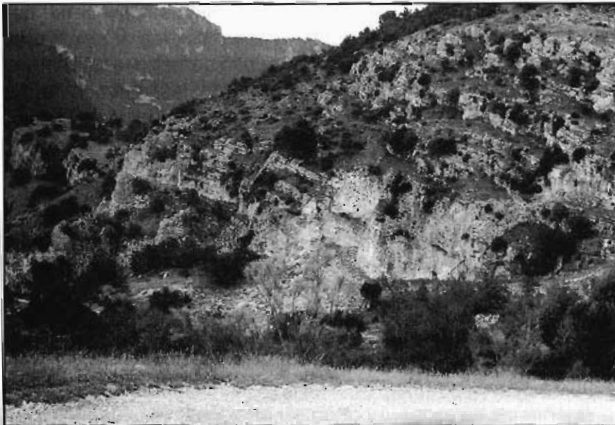
Foto 30.- Afloramiento donde se puede apreciar un desprendimiento en los materiales del grupo 222a en las proximidades de Sta. Cristina, en la carretera de Jaén al embalse de Quiebrajano.
