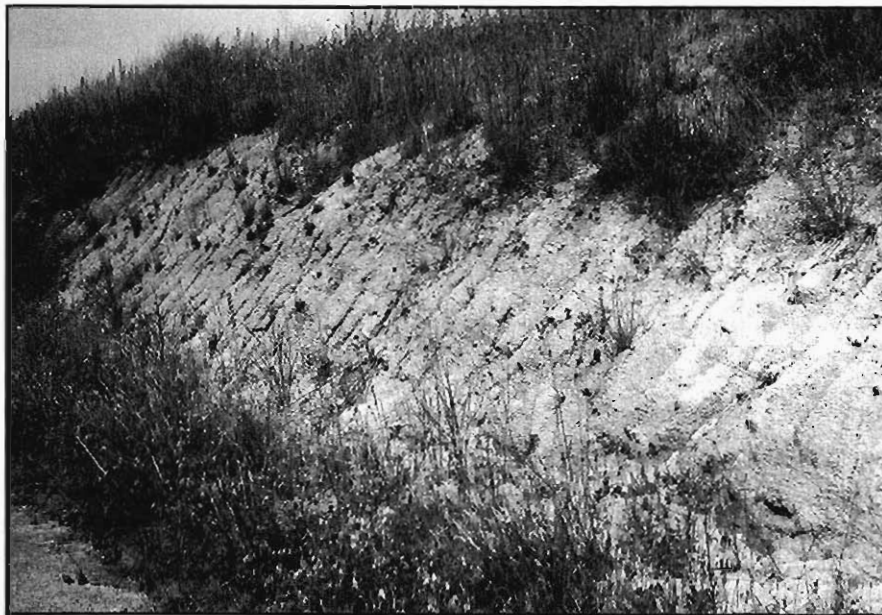
Figura 3.19.- Talud de baja altura excavado en las arenas del grupo (321b), en el que pueden observarse los múltiples canales producidos por la erosión de su superficie. Canal de Villoria, en las proximidades de esta misma localidad (Hoja 479-4).
