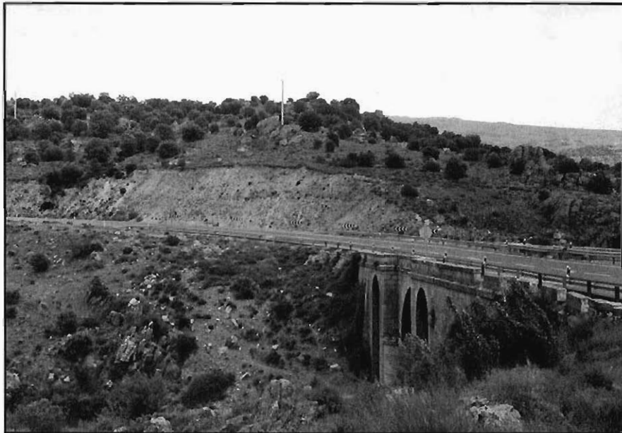
Figura 3.55.- Talud de altura media realizado en "jabre granítico". Osérvese cómo las rocas aflorantes, situadas en la ladera por encima del talud, "flotan" en la masa de suelo residual. Kilómetro 96,8 de la carretera N-501 (Hoja 506-2).
