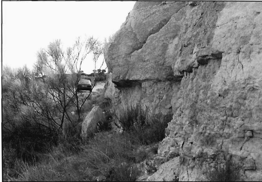
Figura 3.30.- Caída de un bloque de microconglomerado silíceo, por erosión diferencial de las areniscas conglomeráticas, en un talud de baja altura de una de las carreteras del Tramo. El nivel superior del talud corresponde a los microconglomerados, y el inferior a las areniscas. Proximidades de la localidad de Cilloruelo (Hoja 479-3).
