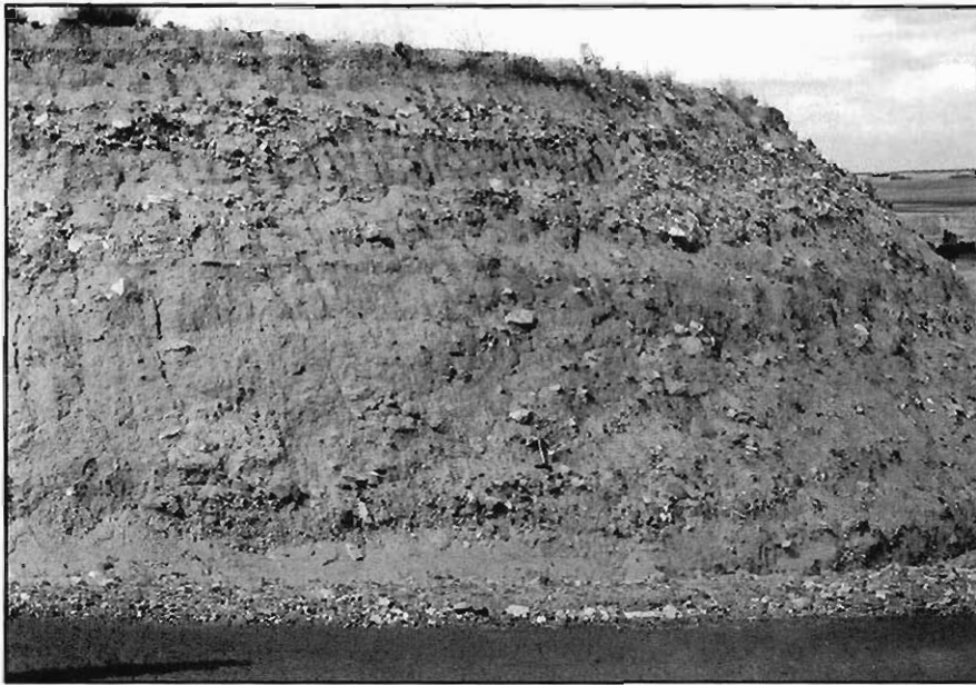
Figura 3.8.- Talud artificial de baja altura, realizado en las arenas y gravas del grupo T1. Puede apreciarse la disposición de los distintos materiales, así como los regueros de erosión y el aterramiento en la cuneta. Proximidades de Gotarrendura (Hoja 506-4).
