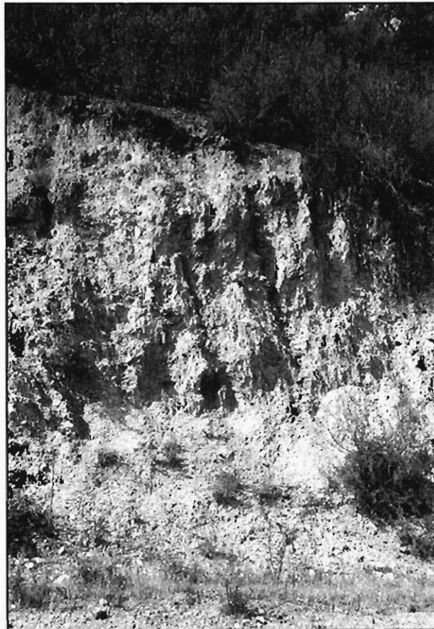
Figura 3.12.- Talud excavado en los esquistos del grupo (121a), en una carretera cortada, en las inmediaciones de Almadén de la Plata. Obsérvese la intensa meteorización que presenta la roca.
