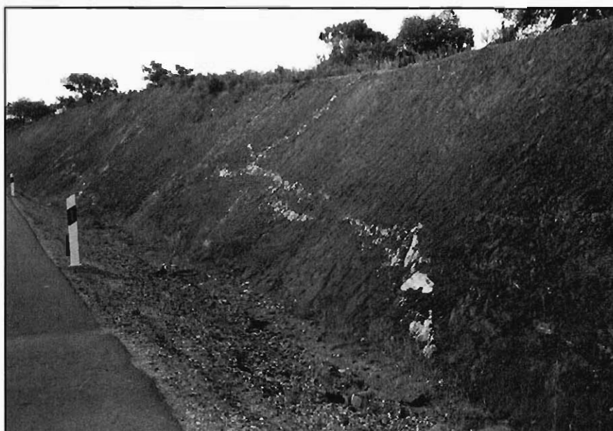
Figura 3.48.- Talud de excavación de los gabros del grupo (001b), en la cortijada de El Alisar. La intensa alteración que presentan ha hecho que no hayan precisado voladura para su excavación. Los niveles blanquecinos que se aprecian en el talud corresponden a diques de cuarzo.
