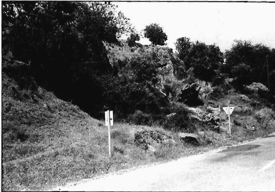
Figura 3.39.- Aspecto de los materiales del grupo (111f) en un talud localizado en las inmediaciones de Almadén de la Plata, en el que se aprecia la presencia de bloques sueltos.
