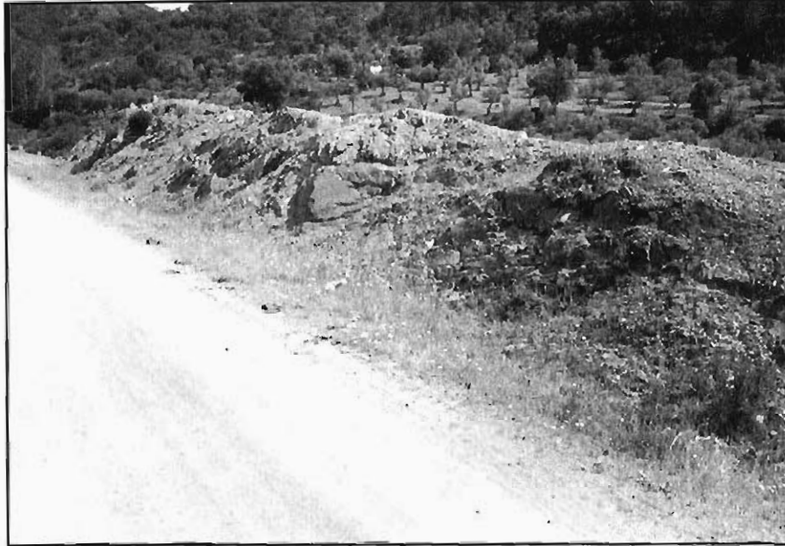
Figura 3.40.- Pequeño desmonte excavado en las pizarras del grupo (010c), en el camino vecinal de Almadén de la Plata a Castilblanco de los Arroyos.
