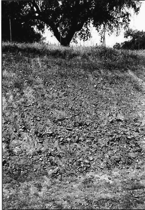
Figura 3.20.- Aspecto de los esquistos del grupo (010a) en un talud situado en el P.K. 44,000 de la carretera N-433.
