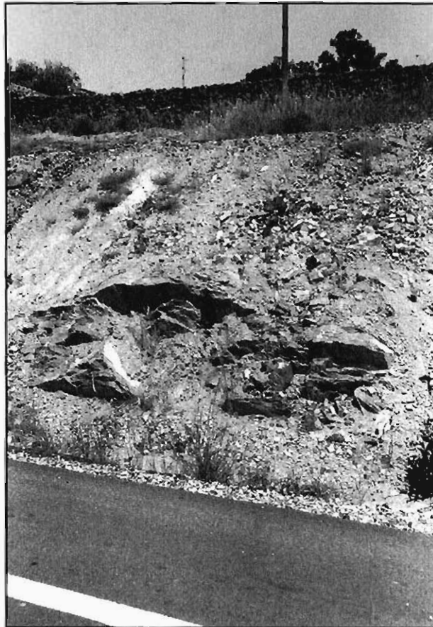
Figura 3.37.- Talud de excavación en los materiales del grupo (131a), en el P.K. 41,000 de la carretera N-433, en las inmediaciones de Higuera de la Sierra.
