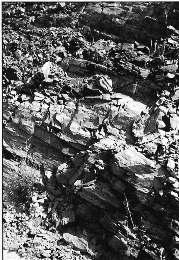
Figura 3.46.- Detalle de las pizarras muy fracturadas del grupo (143b). La fotografía está tomada en un talud de la carretera N-630, a su paso sobre la riberia de Huelva.
