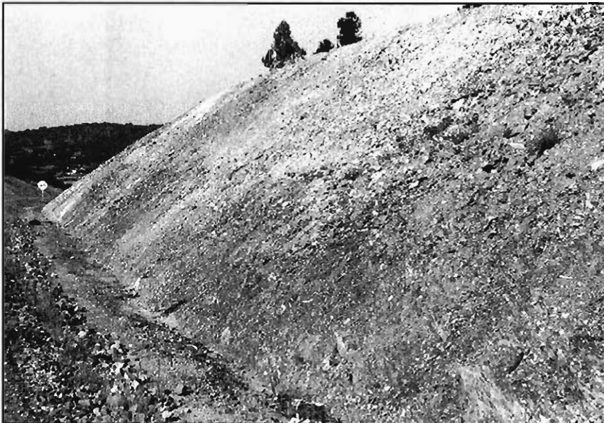
Figura 3.28.- Talud de excavación en los materiales del grupo (151g). El lugar corresponde al P.K. 8,500 de la carretera C-421, en las inmediaciones de La Aulaga.
