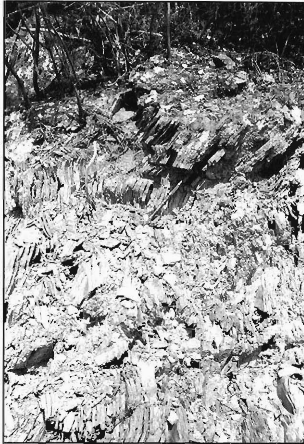
Figura 3.8.- Detalle de las pizarras del grupo (151i) en un desmonte situado en el P.K. 5,000 de la carretera de Almadén de la Plata a El Real de la Jara. Obsérvese el intenso plegamiento que presentan.
