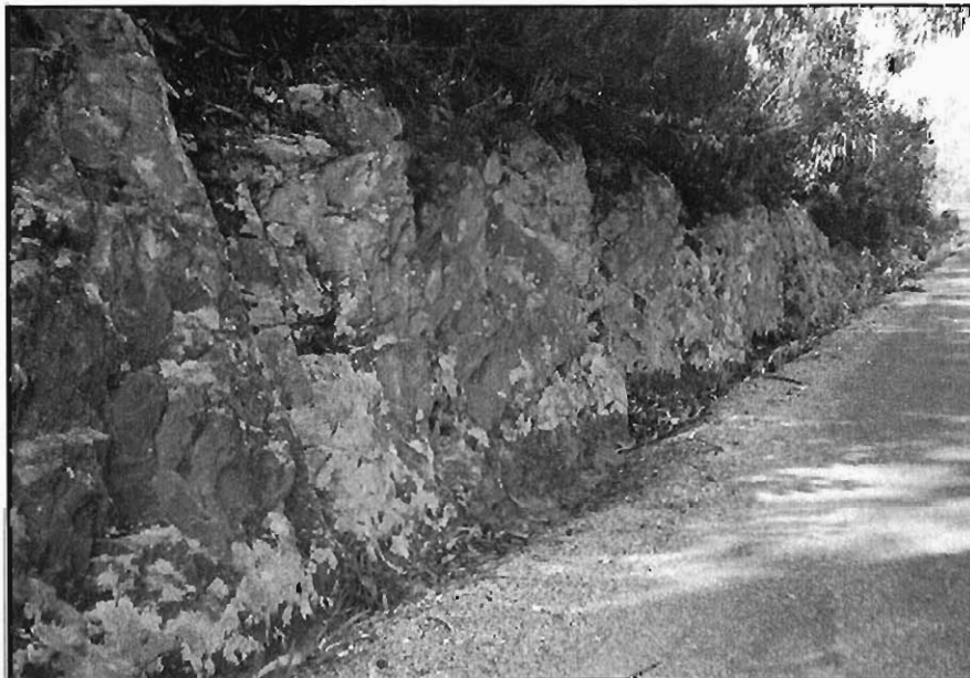
Figura 3.35.- Aspecto de las pizarras del grupo (151a) en un pequeño desmonte situado en el P.K. 13,000 de la carretera de La Aulaga a El Madroño.
