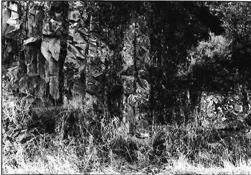
Foto 4.- Alternancia de pizarras y areniscas constitutivas del grupo litológico (111f). Talud excavado en el P.K. 120,5 de la carretera N-435.
