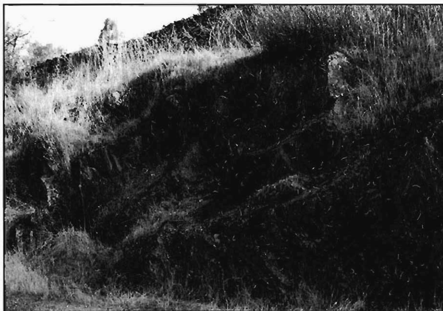
Foto 6.- Esquistos grauváquicos pertenecientes al grupo litológico (111d). En esta foto se puede observar el carácter esquistoso y oscuro, así como el gran número de planos de diaclasado que caracteriza al grupo. Talud excavado en el P.K. 31 de la carretera C-4311.
