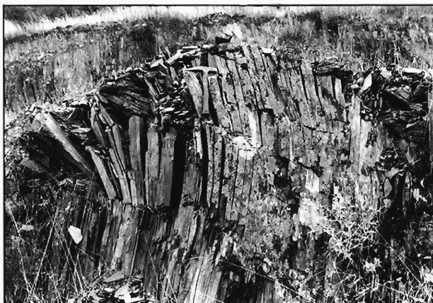
Foto 21.- Alternancia rítmica de pizarras, grauvacas y areniscas, constituyente de la formación "flysch de Terena". Grupo litológico (141a). En la fotografía se puede observar un incipiente vuelco de estratos. Talud excavado en el P.K. 2,5 de la carretera que une las localidades de La Nava y Encinasola (esta última fuera del Tramo).
