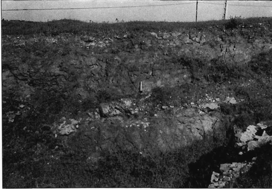
Fig. 3.20.— Excavación en las anfibolitas del grupo (010h), localizada en la carretera de Villafranca de los Barros a Ribera del Fresno. Obsérvese, en la parte izquierda, la montera de alteración que presentan.
