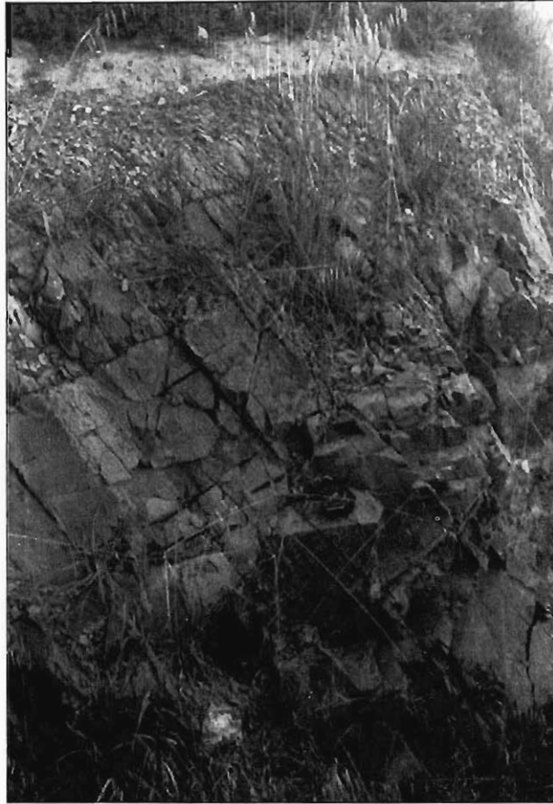
Fig. 3.47.— Detalle de las pizarras en un pequeño desmonte, en las inmediaciones de la carretera de Zafra a La Lapa.
