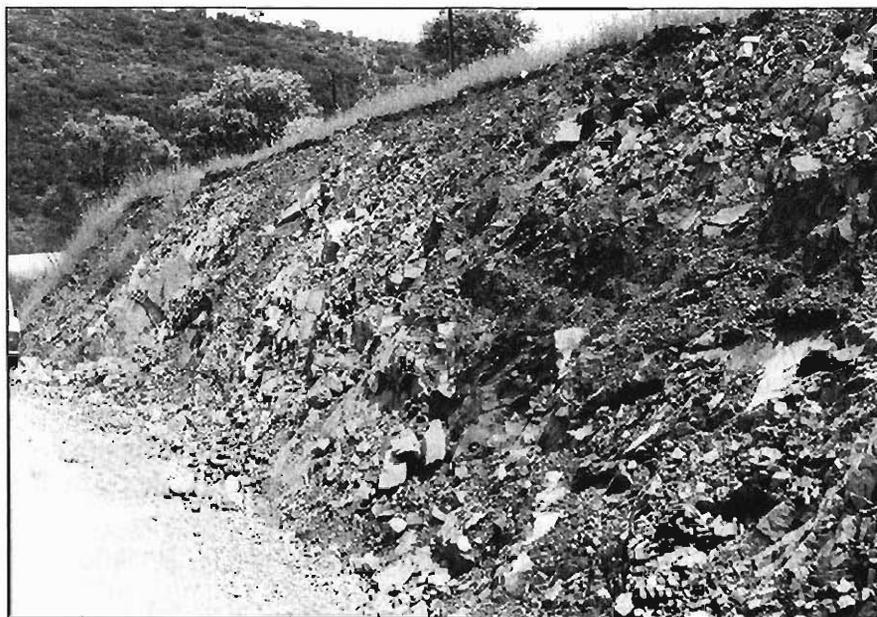
Foto 13. - Talud excavado en las rocas volcánicas (metavulcanitas) del grupo litológico (112a). P.K. 2 de la carretera de La Parra a Fuente del Maestro.
