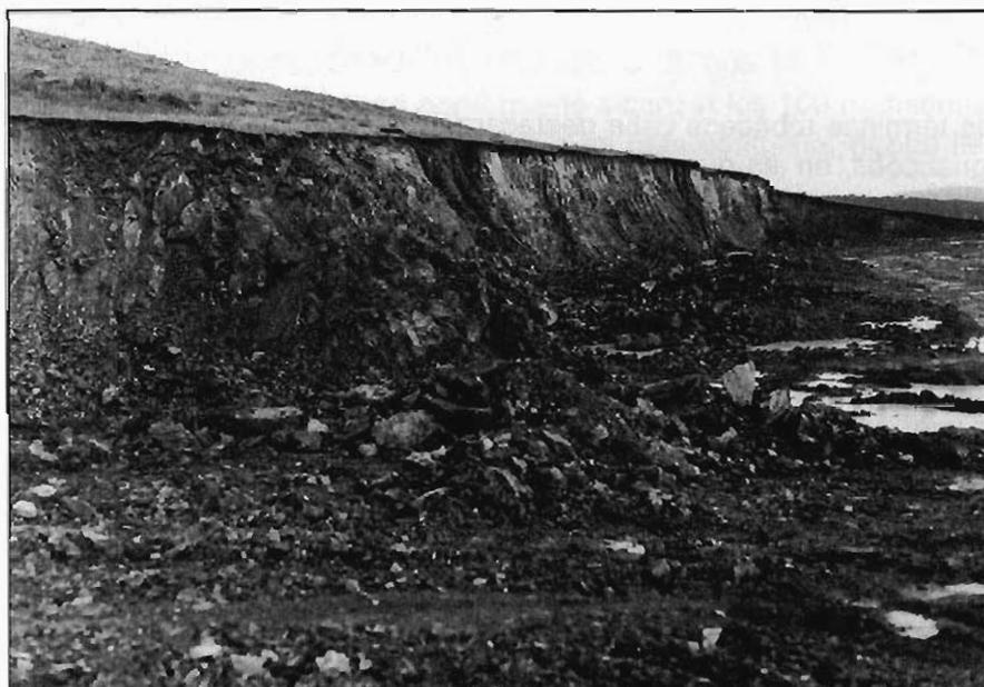
Foto 14. - Talud excavado en los materiales del grupo litológico 151, en las proximidades de Valverde de Leganés.
