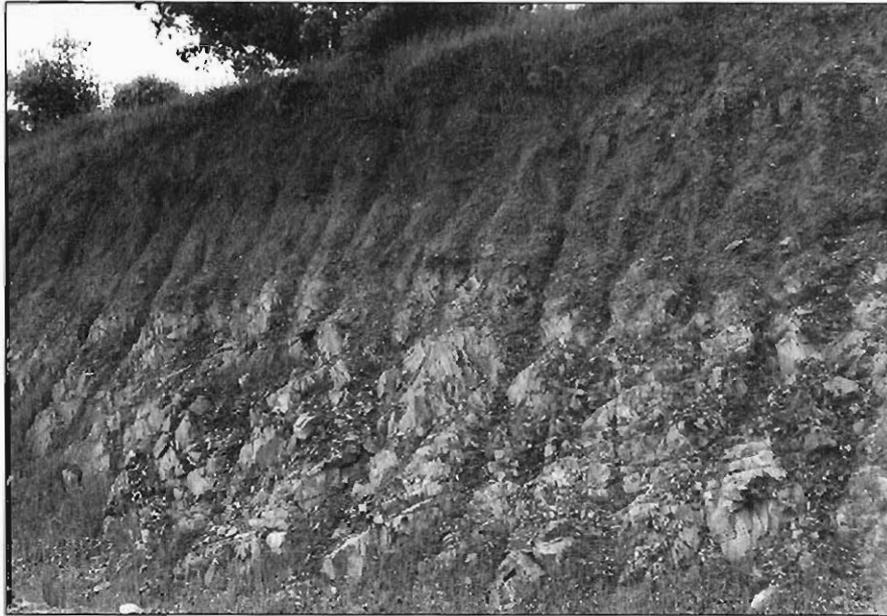
Foto 12. - Talud estable excavado en el grupo litológico (111d). P.K. 1 de la carretera de La Parra a Fuente del Maestro.
