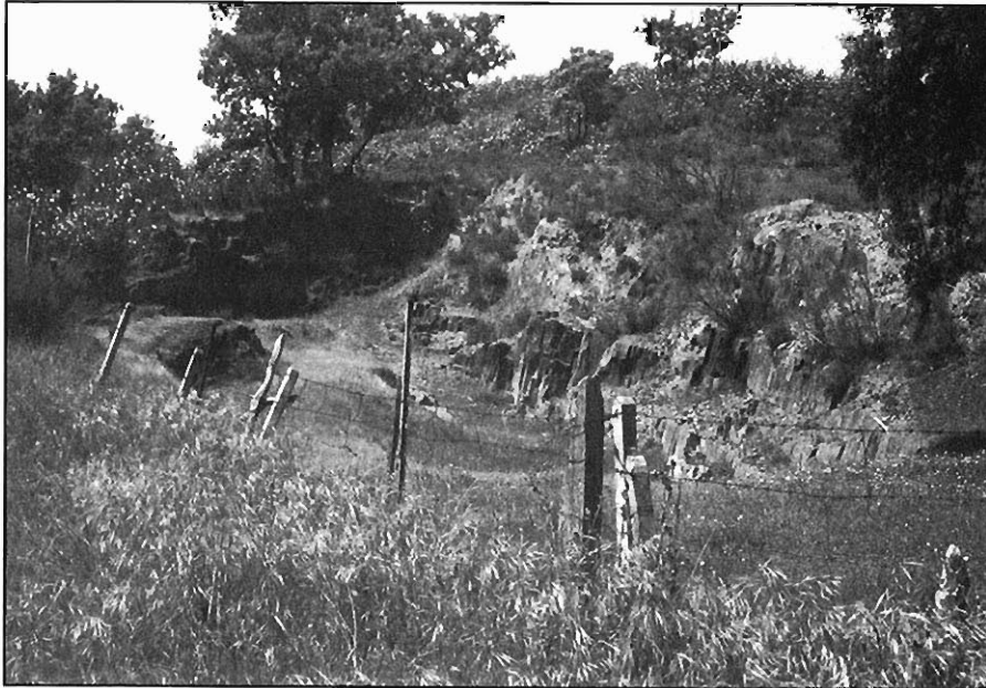
Foto 40.- Explotación abandonada del yacimiento C-7 (grupo 010b) en el P.K. 5,5 de la carretera C-501.
