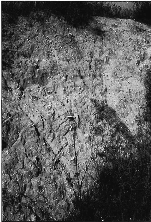
Foto 23.- Arenas y arcillas del grupo (321c) en el P.K. 8 de la carretera local de Plasencia a Montehermoso.
