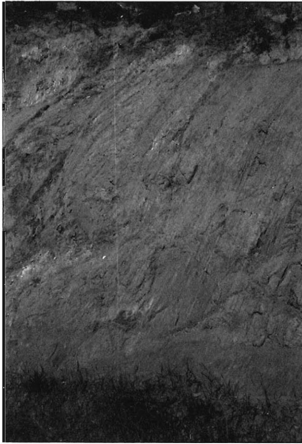
Foto 15.- Pizarras rosadas (010a) bajo coluvial, en la ladera meridional de la Sierra de Santa Catalina, en el P.K. 17 de la carretera local de Serradilla a Mirabel.
