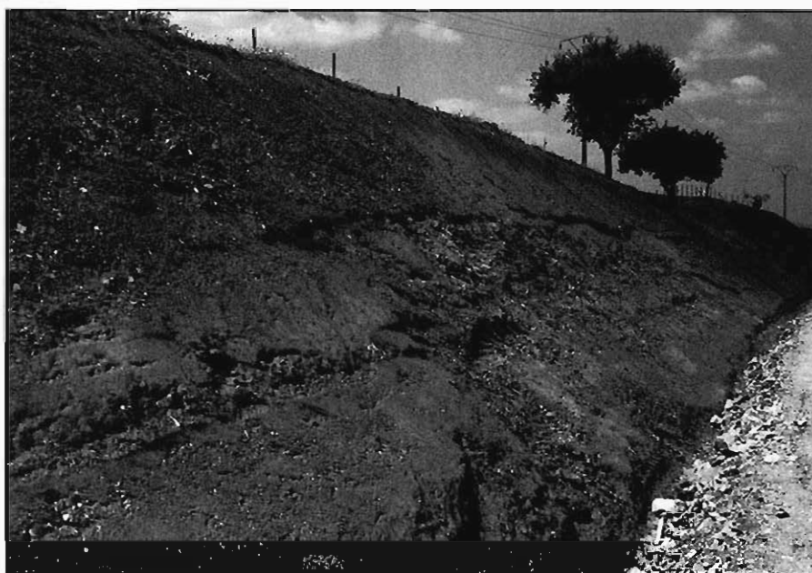
Foto 21.- Materiales del grupo (321b) en el P.K. 3,5 de la carretera local de Galisteo a la carretera N-630.
