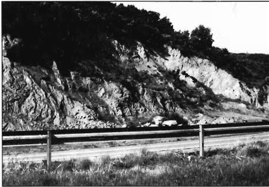
Fig. 4.4.— Deslizamiento de ladera superficial desarrollado en el grupo VI.
