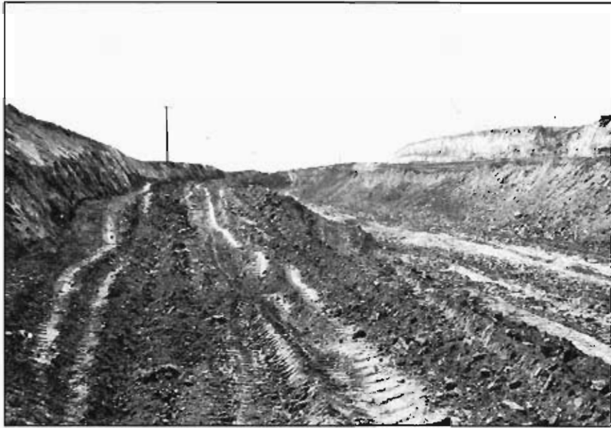
Fig. 3.50.— Taludes excavados en el grupo V2, en las proximidades de Guijuelo, para la carretera de Salamanca a Cáceres.
