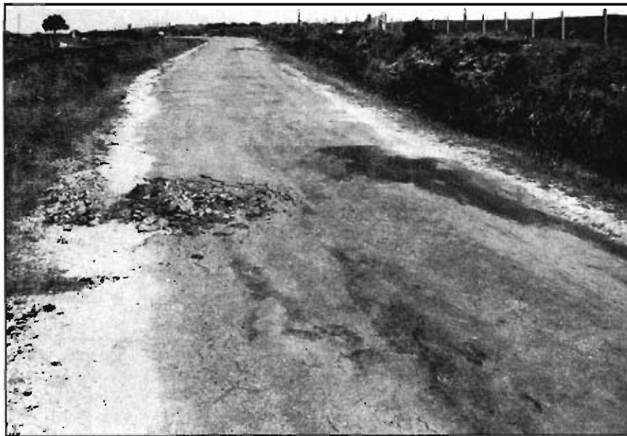
Fig. 4.5.— Blandones producidos en una de las carreteras del Tramo.
