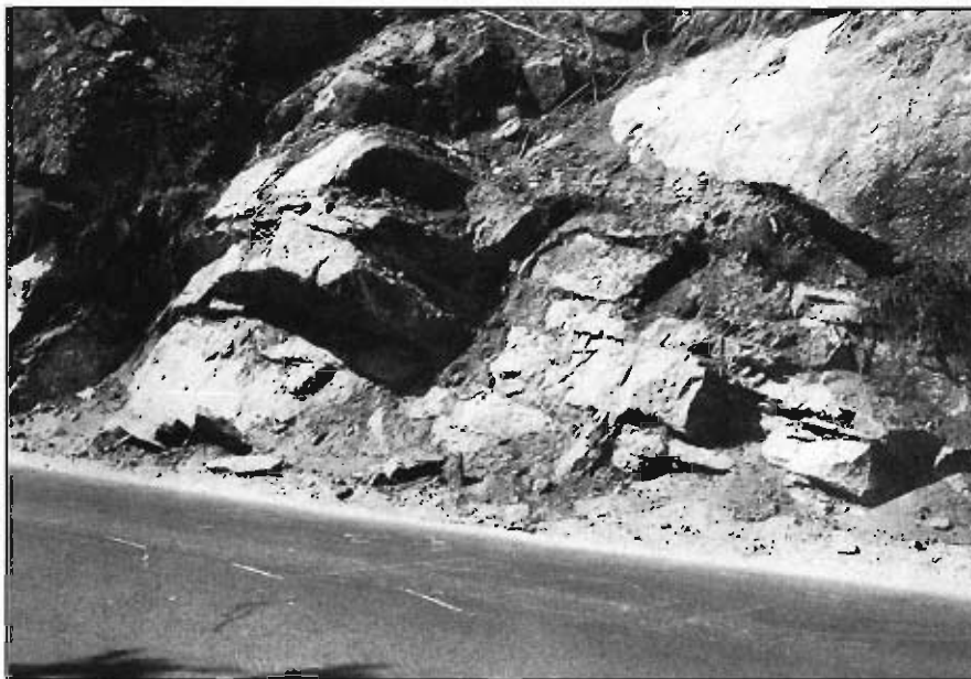
Fig. 4.2.— Desprendimientos de bloques en materiales graníticos.
