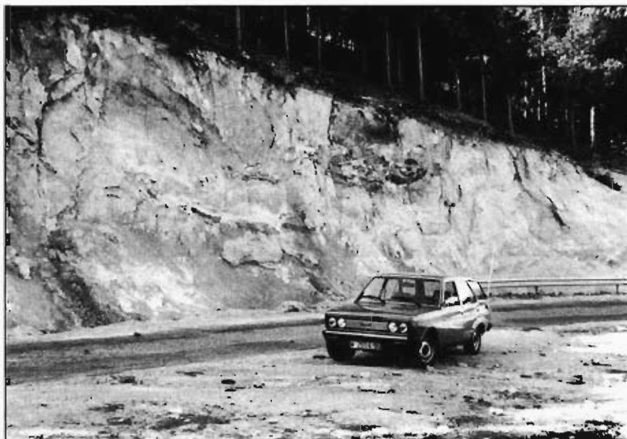
Fig. 3.33.— Talud excavado en el grupo VI. Obsérvese la potencia que puede presentar. Carretera de Béjar al Mirador de la Sierra (553-3).
