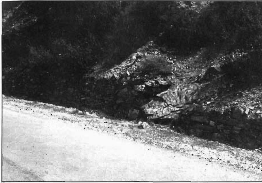
Fig. 4.3.— Muro de contención sujetando un pequeño deslizamiento superficial de materiales correspondientes al grupo C3.
