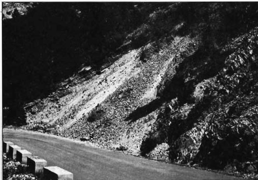
Fig. 3.13.— Deslizamiento de ladera superficial del grupo C3 en las inmediaciones del puerto de El Portillo (552-4).
