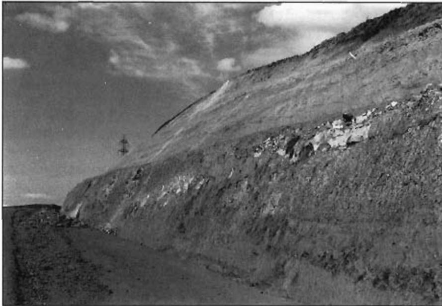
Foto 8.— Niveles areniscosos y margosos en un talud de la nueva carretera de circunvalación de Salamanca, al Oeste de dicha ciudad.
