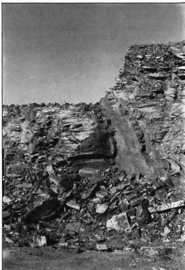
Foto 38.— Talud de excavación en la nueva carretera de circunvalación de Salamanca por el Oeste. Pizarras del grupo 121c. Se puede observar una clara problemática de inestabilidad de bloques y cuñas.
