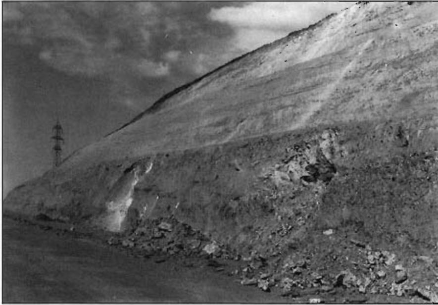
Foto 11.— Talud de excavación en materiales del grupo 312, situado en la carretera de circunvalación existente al Oeste de la ciudad de Salamanca. La existencia de un nivel margoso impermeable en la base del mismo ha propiciado la aparición de algunos desplomes.
