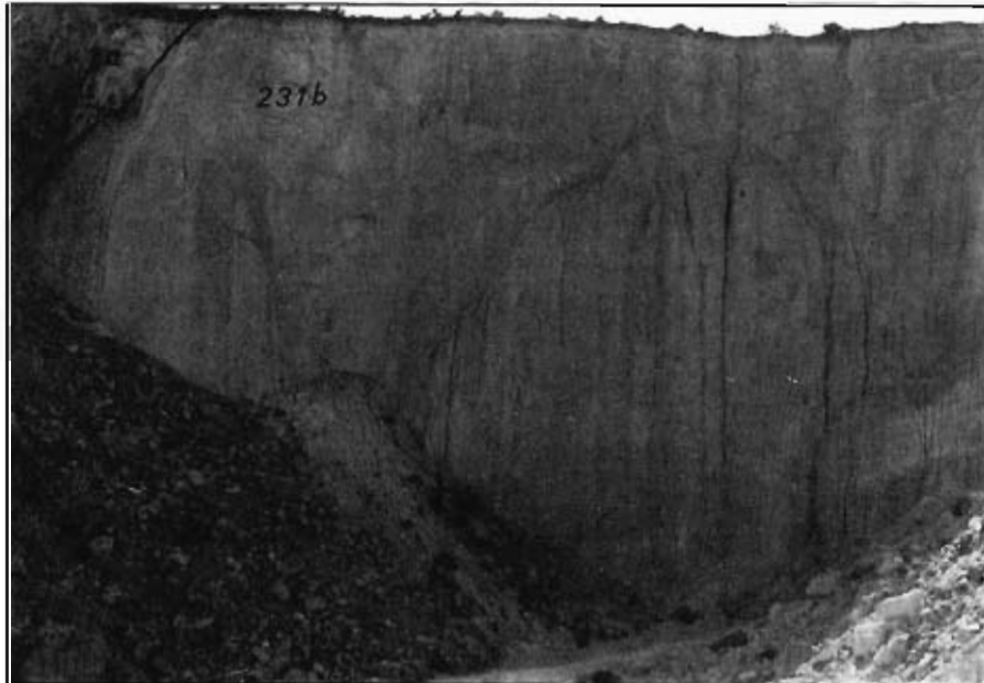
Foto 8.— Grupo 231b. Corte del frente de explotación de las arenas de Utrillas, en Olmos de Atapuerca.
