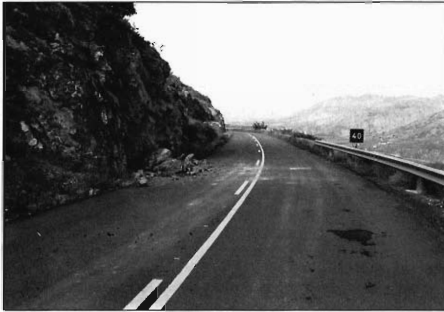
Foto 35.— Grupo 213a. Desprendimientos en yesos, favorecidos por la karstificación. Carretera de Ribaflecha a Leza de Río Leza.
