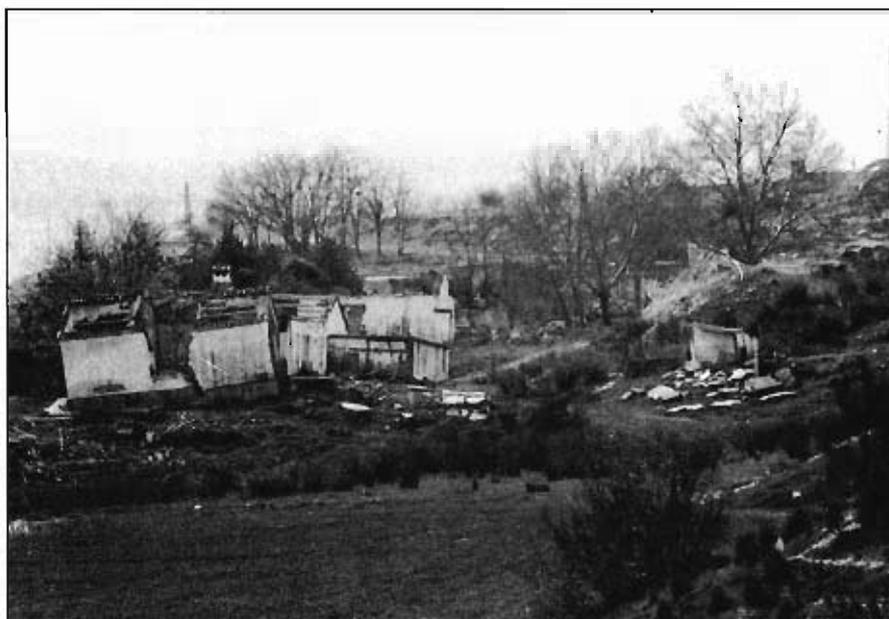
Foto 37.— Efectos catastróficos en edificios causados por un deslizamiento ocurrido en las margas del grupo 230.
