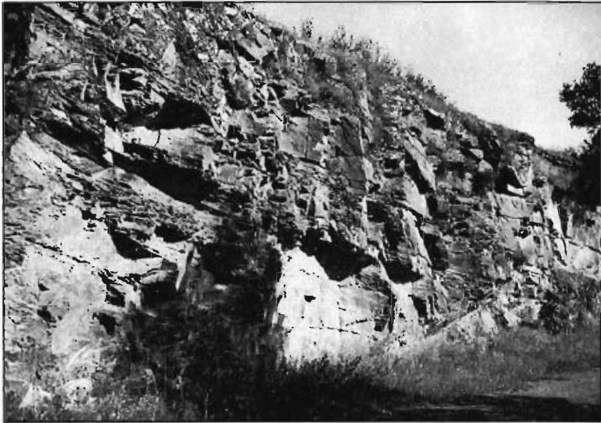
Foto 10.— Talud artificial en las pizarras carboníferas del grupo 150.
