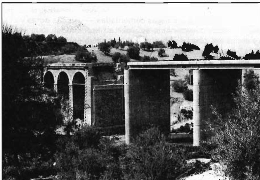
Foto 28.— Puente destruido por la erosión torrencial y cimentado sobre los materiales del grupo 321b.
