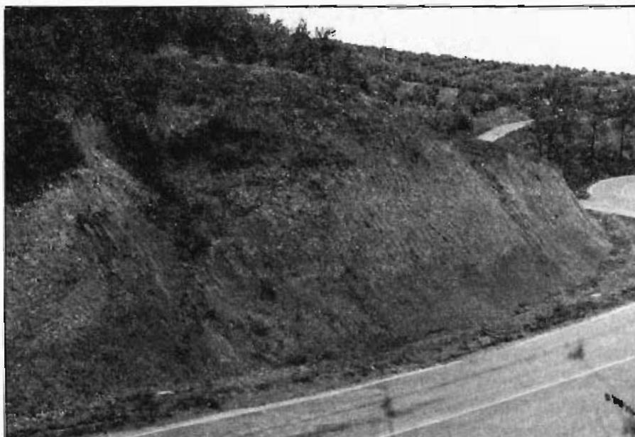
Foto 24.— Talud en el grupo 321c, afectado por un pequeño deslizamiento, en las proximidades de Torreperogil.
