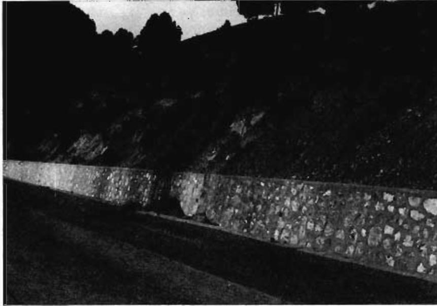
Figura 3.64.— Aterramiento de cunetas a consecuencia de la reptación de las arcillas del grupo 210c.
