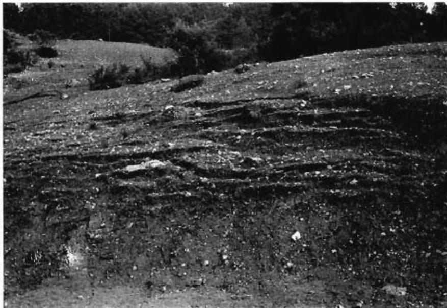
Figura 4.3.— Detalle de un deslizamiento en los materiales del Keuper. Carretera Onsares-Los Maridos (Hoja 865-1).
