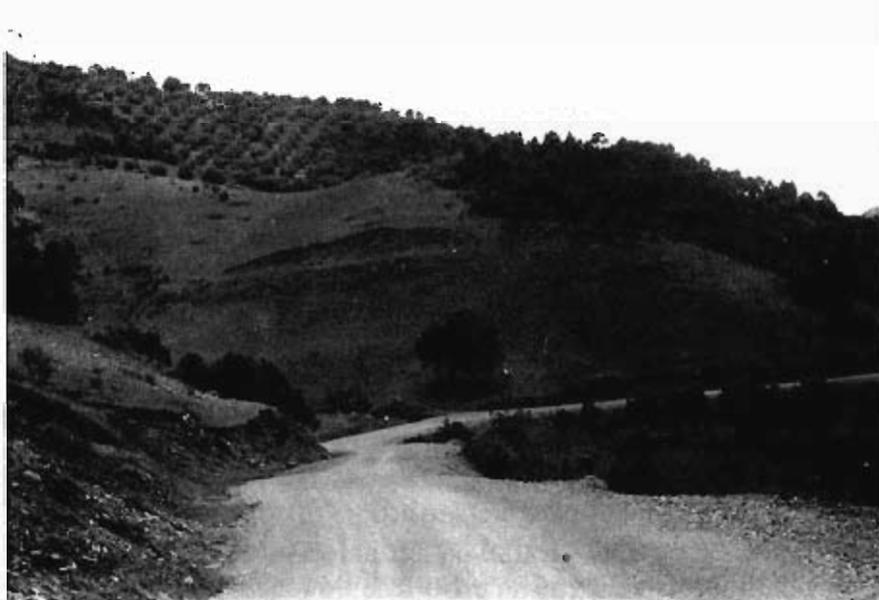
Figura 4.2.— Deslizamiento en las margas yesíferas alteradas del Keuper (grupo 213), en la carretera local que enlaza las poblaciones de Onsares y Los Maridos (Hoja 865-1).
