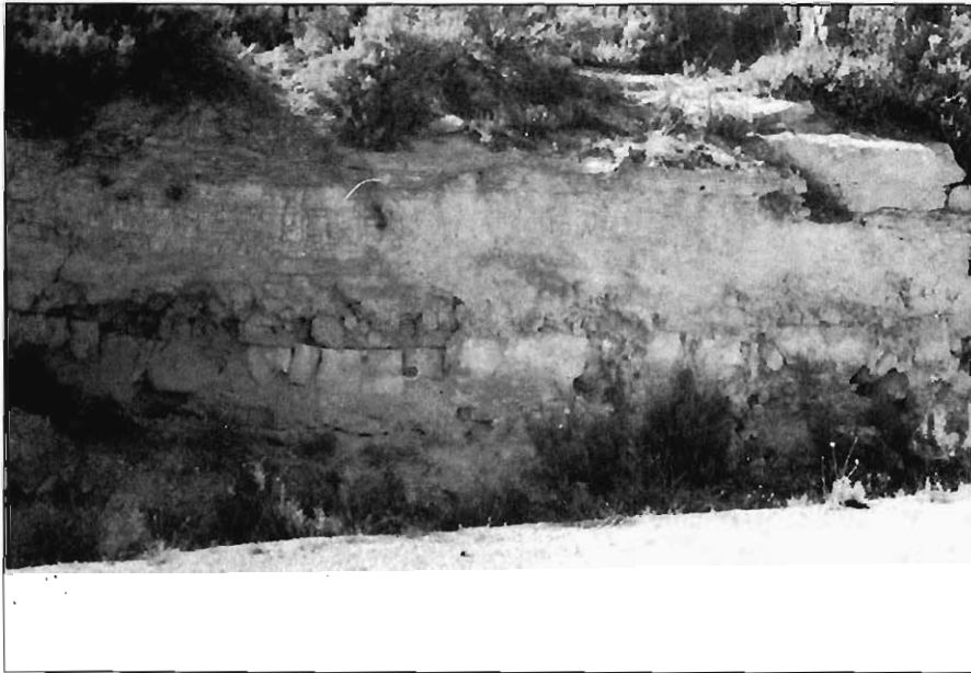
Foto 46.— Aspecto del grupo 322a en un talud artificial.
