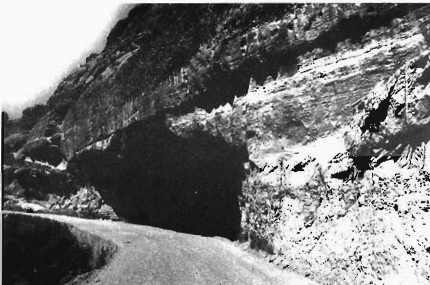
Foto 9.- Talud en voladizo de la Molasa (321b).
