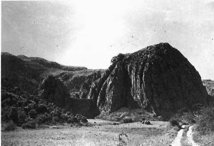
Foto 49.— Detalle de la presa de Montejaque apoyada en calizas jurásicas.
