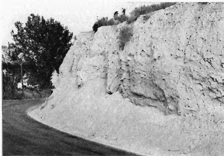
Fig. 46. Margas arcillosas del grupo 321i. Talud en la C.N. 332 al S. de Cuevas de Almanzora.
