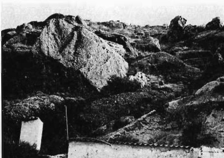
Fig. 67. Deslizamiento de conglomerados del grupo 322b2, compacto, sobre el 321d2, blando, en el P. K. 27 de la C.N. 322.
