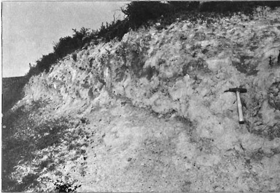
Foto 30.— Aspecto de un desmonte parcialmente derrubiado en las margas de Fuendejalón (321g). Foto tomada en las proximidades de esta localidad.
