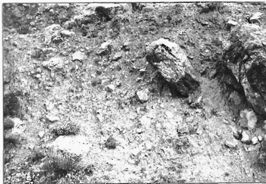
Foto 12.— Detalle de los coluviales (C4) en uno de los desmontes de la carretera local de Calcena a La Purujosa.
