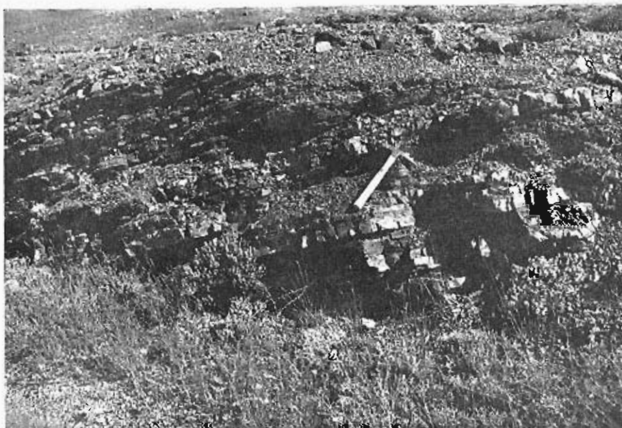
Foto 78.—Detalle de un pequeño desmonte en las pizarras y areniscas de Oseje, bien estratificadas y buzando hacia el Oeste. Carretera Z-343, al oeste de Jarque.
