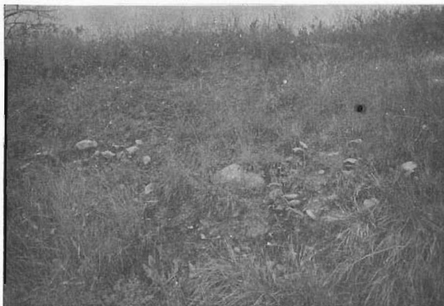
Foto 74.— Desmonte en los depósitos AC6. Foto tomada en la carretera local de Calceña a Oseja.
