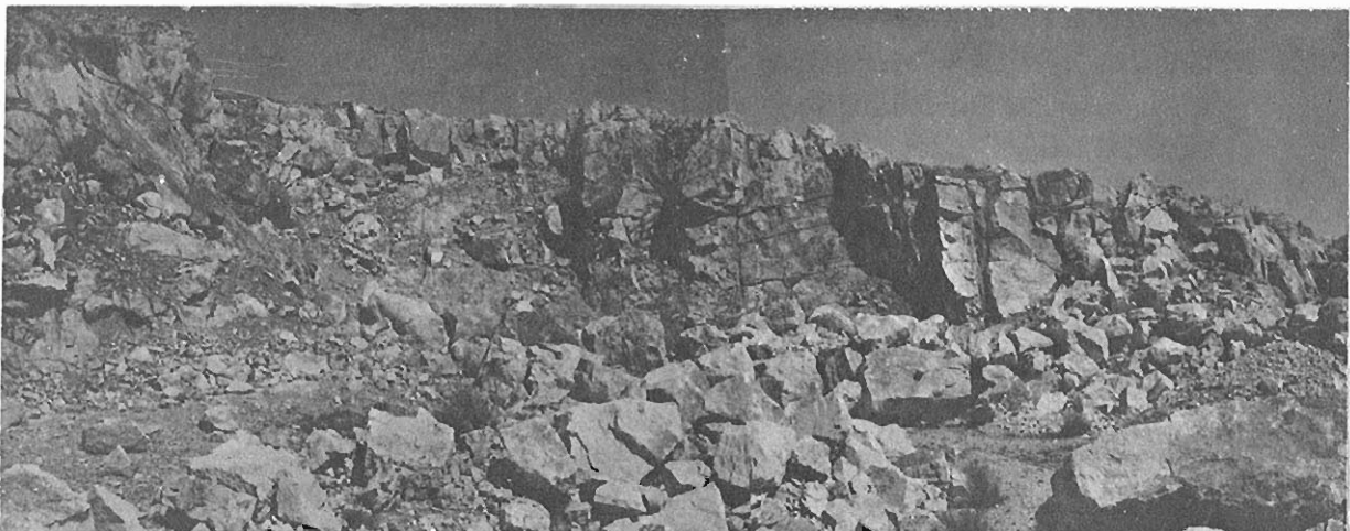
Foto 80.— Yacimiento rocoso núm. 1. Cantera abandonada de calizas (grupo 232). Carretera N 234 P.K. 29,200
