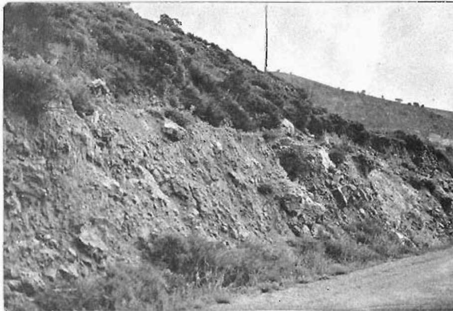
Foto 11.— Coluviales (C4) en el corte dado por la carretera local de Calca a La Purujosa.
