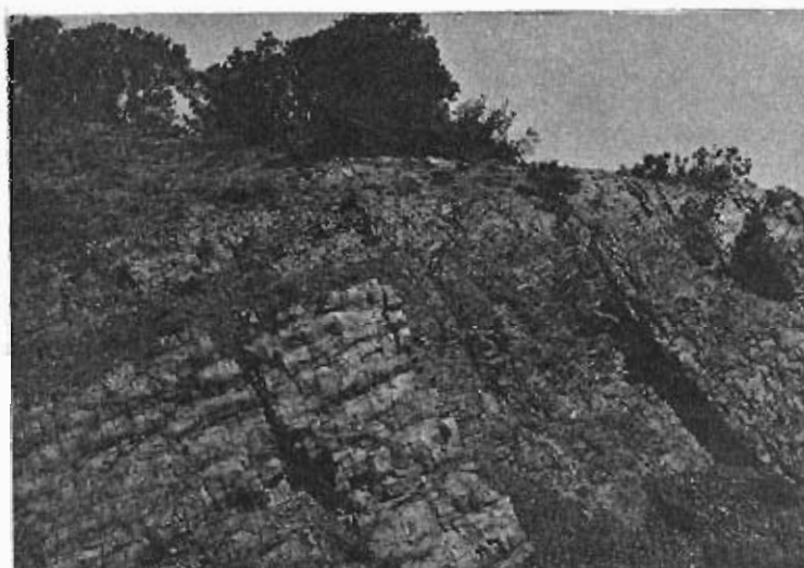
Foto 79.—Afloramiento de pizarras (110b) en el P.K. 12 de la carretera local entre La Alameda y Carabantes.
