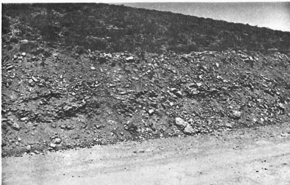
Foto 21.— Taludes artificiales del grupo 221b cerca de Olmedillas
