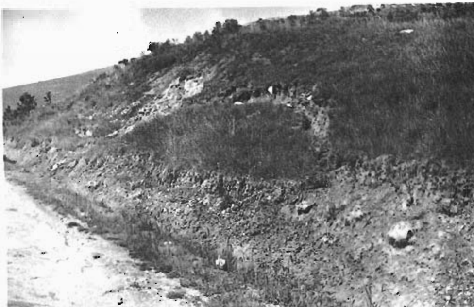
Foto 13.— Deslizamiento de taludes en arcillas del Keuper. (213)
