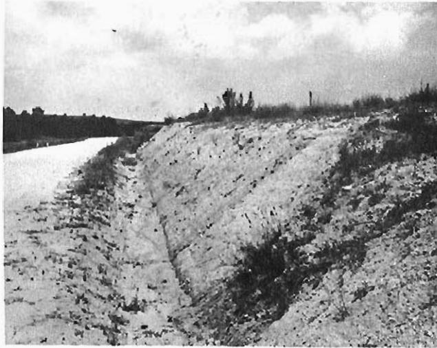
Foto 21.— Talud artificial, bien conservado. Sobre los depósitos arcósicos miocenos (321)
