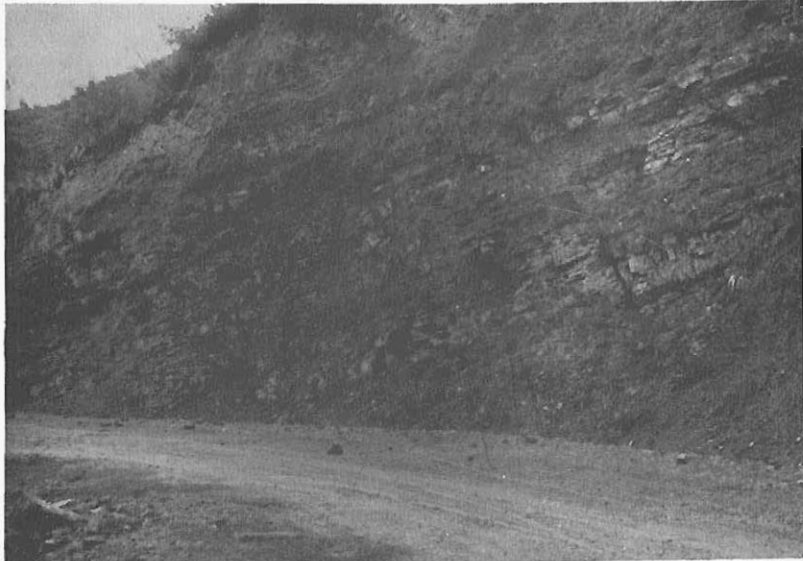
Foto 26.— Talud artificial excavado en las areniscas y limolitas del Puerto del Escudo, (Cuadrante 58–3).
