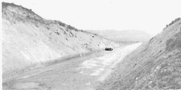
Foto 7.— Taludes artificiales tallados en los materiales de Facies Keuper, Carretera local S-233. (Cuadrante 83-3).
