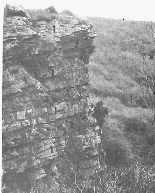
Foto 4.— Talud natural verticalizado en las areniscas (1) y aleuritas (2) del grupo 162a. (Cuadrante 83–4).
