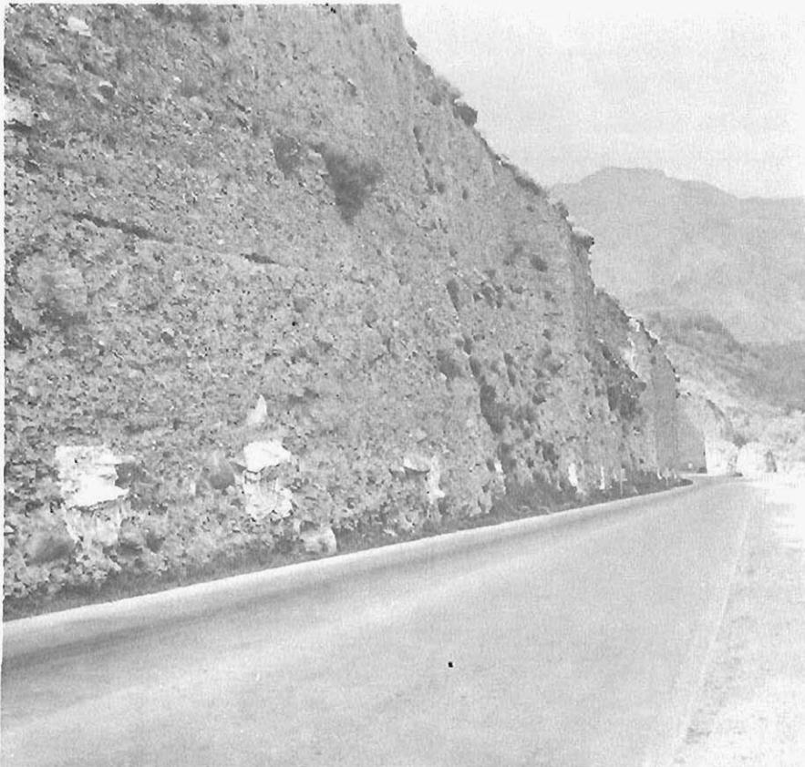
Foto 6.— Desmonte subvertical en depósitos pliocenos (350a) de la carretera N—323.
