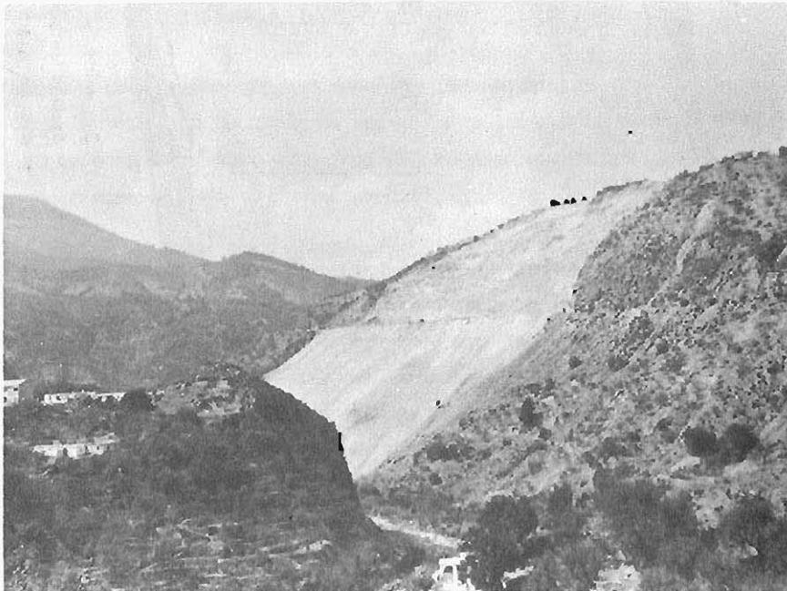
Foto 22.— Gran deslizamiento de neises bandeados y esquistos (100i) en la carretera N-323
