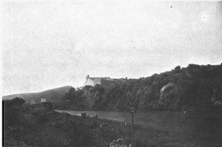
Foto 31.— Taludes de 80° en 2 m de altura en materiales triásicos; no se llegan a cegar las cunetas. P.K. 352 de la C.N.—301. (Cuadrante 891—3).
