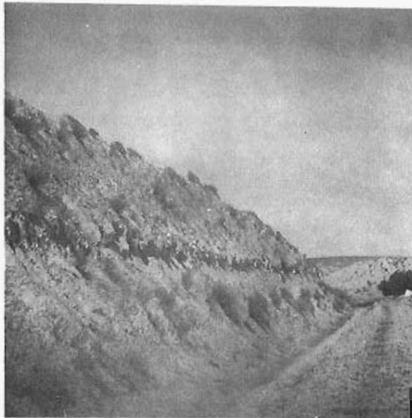
Foto 106.— Taludes artificiales fallados en las margas del río Mula para el trazado del F.C. Murcia—Caravaca. (Cuadrante 912—2).
