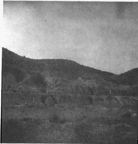
Foto 113.— Cárcavas en los taludes de la C.L.—MU—V—5332, arcillas del grupo 34j'. Cuadrante (912—1).
