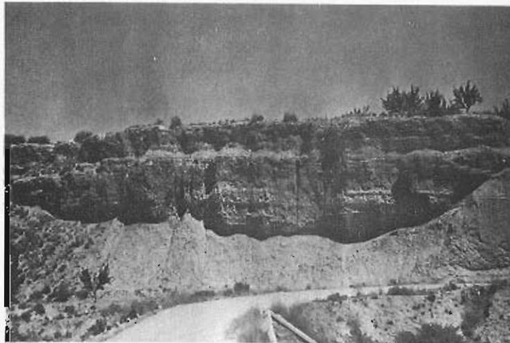
Foto 3.— Diferente comportamiento de las arcillas pliocenas (taludes verticales) y de las margas miocenas (taludes tendidos y acaravados). (Cuadrante 912-4).
