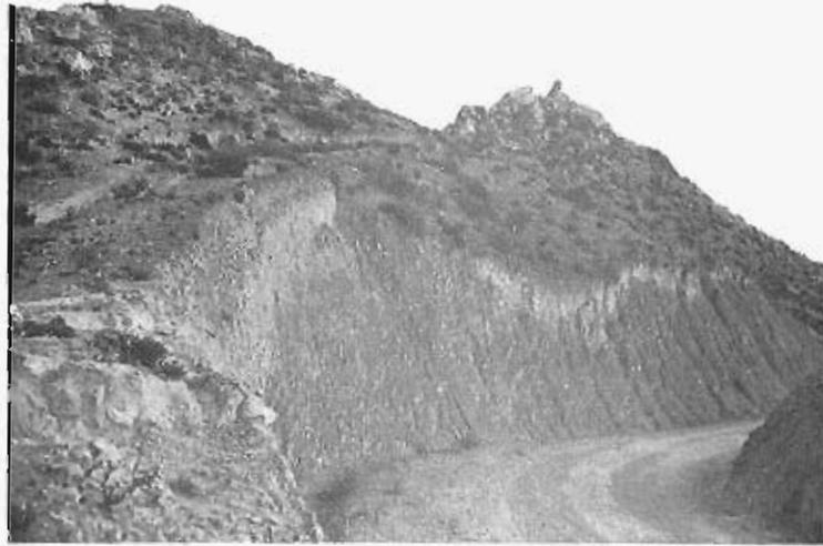
Foto 24.— Taludes con costras de alteración sobre las margas yesíferas del Mioceno superior. Cuadrante 912-4).
