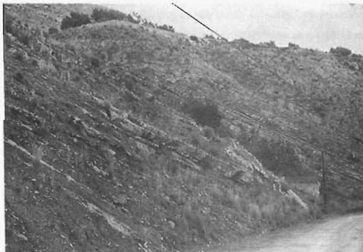
Foto 43.— Taludes en cuesta estructural descalzada entre Blanca y Abarán. Buena estratificación de las calizas, margas y areniscas, del grupo 33e. (Cuadrante 891—3).
