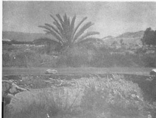
Foto 25.— Rotura del muro de contención y terraplén en la C.L. MU-V-4121, proximidades de Fortuna, por deslizamiento de las margas miocenas infrayacentes. (Cuadrante 892-3).
