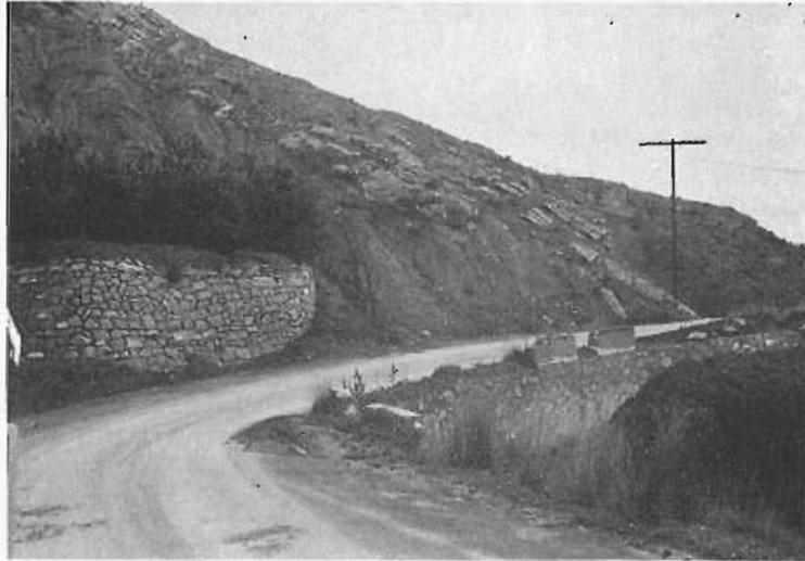
Foto 44.— Desprendimiento de las calizas, margas y areniscas tableadas en la C.L. MU—. (Cuadrante 891—3).
