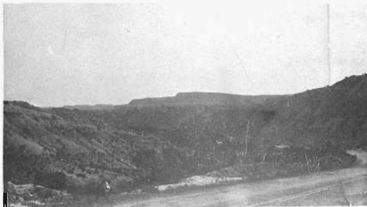
Foto 23.— Taludes en margas con yesos del Mioceno superior con alturas de 7-8 m e inclinación de 45°. (Cuadrante 912-3).
