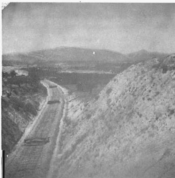
Foto 108.— Taludes tallados en los yesos del Montañal. (Cruce del F.C. MU—531).
