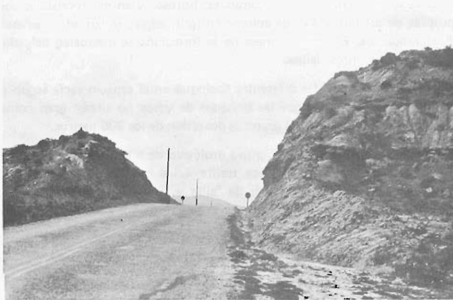
Foto 14.— Taludes en la facies Requena (36 n). Carretera de Requena a Campo Arcís.
