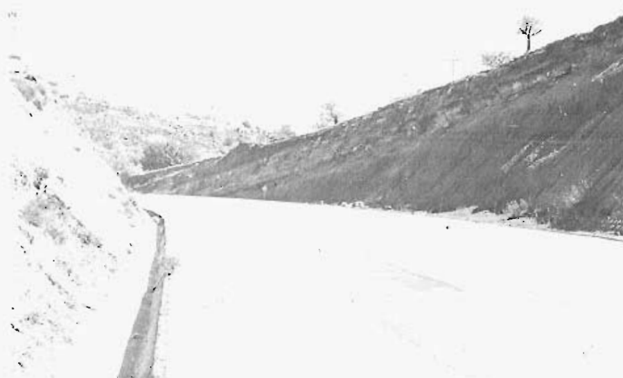
Foto 51.— Talud artificial en el grupo 36 o, de arcillas y calizas con intercalaciones de conglomerados y arenas
