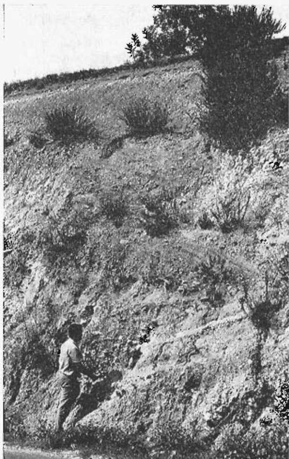
Fig. 45. Talud en el glacis aluvial (37 a), en el valle del río Francolí, carretera de Morell.
