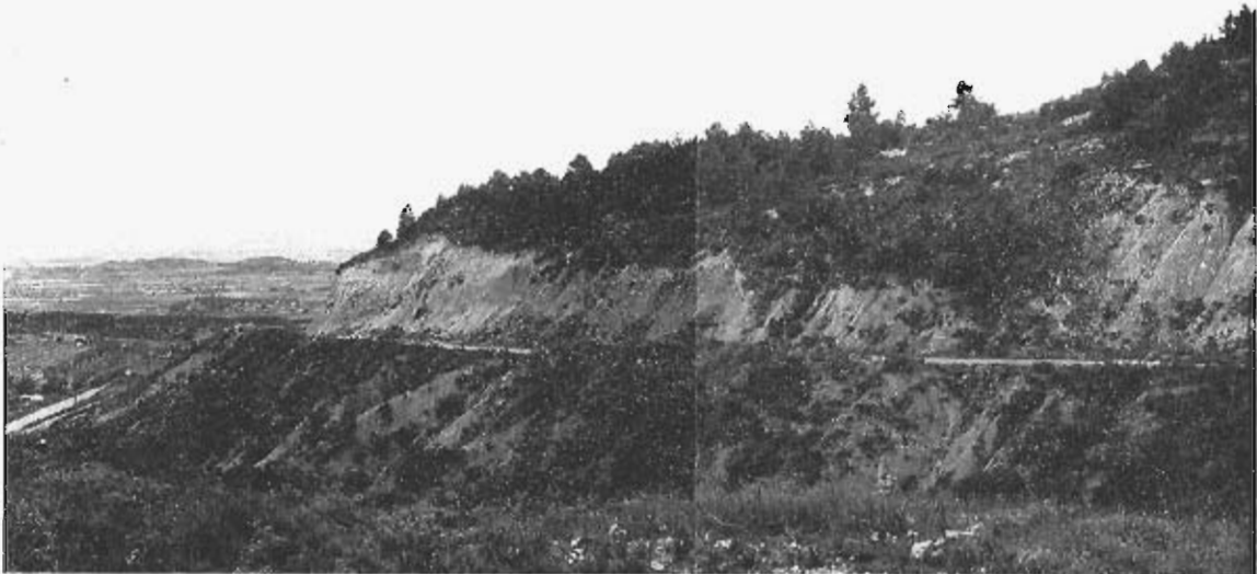
Fig. 14. Talud del grupo 31 b en la carretera nacional subiendo al puerto de Lilla.
