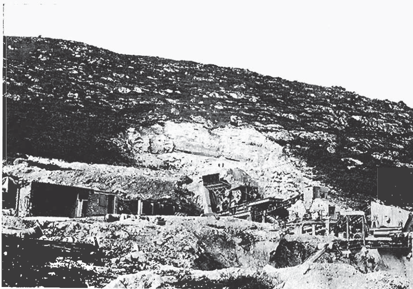
Fig. 55. Cantera en las dolomías del Lías (24 a), al suroeste de Montblanch. Fig. 56. Cantera en las calizas del Cretácico (28 a) al norte de Tarragona.
