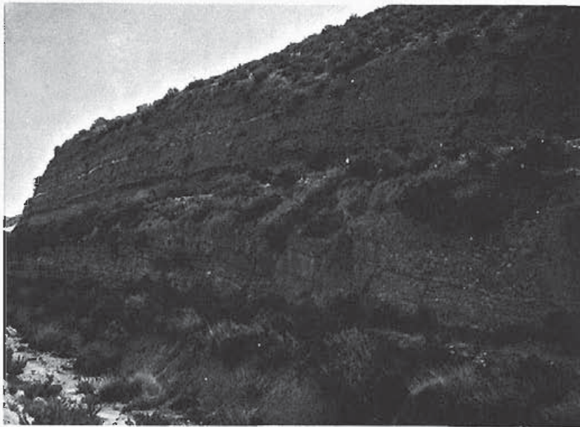
Foto 38.—Talud artificial de los yesos de la margen del Canal Imperial de Aragón — 32a.
