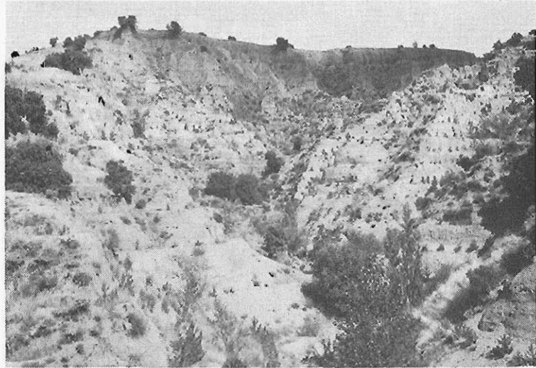
Fig. 19. Talud de unos 50° de pendiente continua y unos 15 metros de altura en el kilómetro 111 de la C. N.—1
