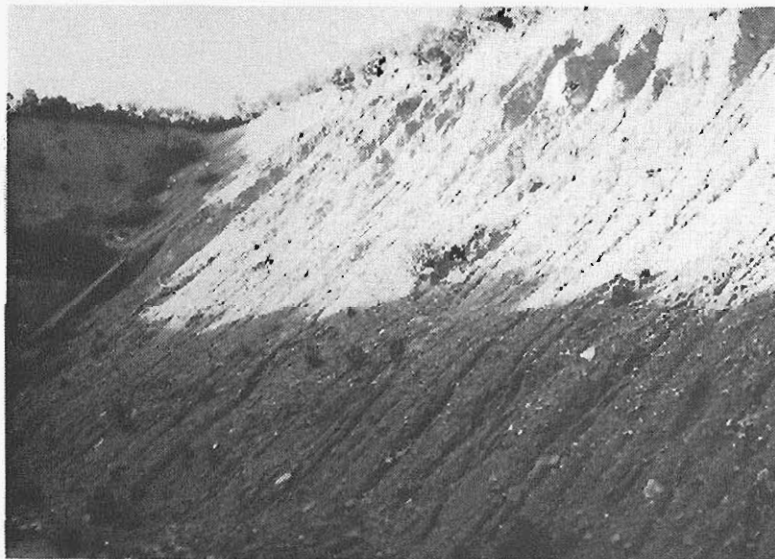
Fig. 21. Talud del FF. CC. Madrid-Burgos en las proximidades de la C. N. Soria-Plasencia; tiene 50^\circ de pendiente continua y de 12 a 15 metros de altura
