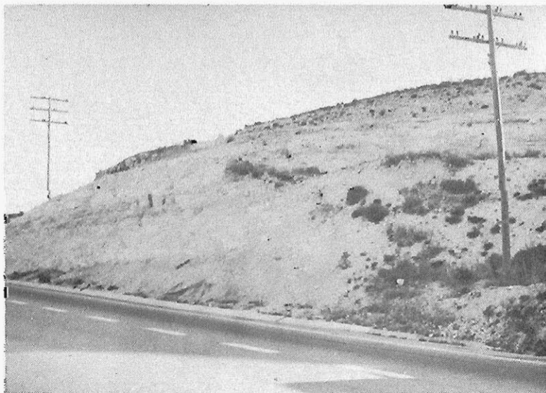
Fig. 47. Talud de la C. N.—l Madrid-Burgos en el kilómetro 150, constituido por calizas pontienses sobre margas blanquecinas
