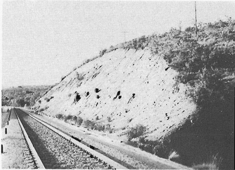
Fig. 20. Talud del FF. CC. Madrid-Burgos, frente al kilómetro 66 de la C. N. Soria-Plasencia; tiene 50^\circ de pendiente continua y de 12 a 15 metros de altura
