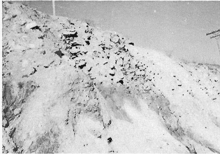
Fig. 9. Detalle de los coluviales de Somosierra que aparecen entre los kilómetros 94 y 95 de la C. N.-1
