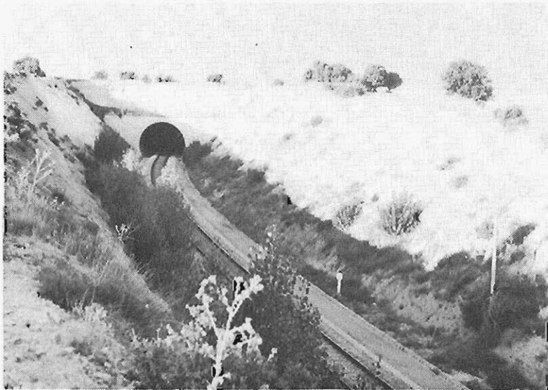
Fig. 45. Arcillas margosas que aparecen en el talud del FF. CC. Madrid-Burgos, paralelamente a la carretera Sta. Cruz de la Salceda-Linares del Arroyo, a la altura del kilómetro 40. Boca norte del túnel
