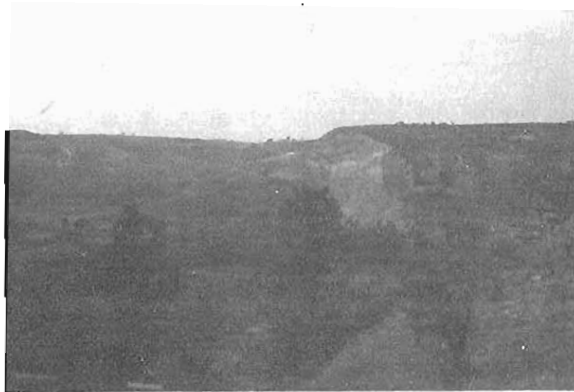
Foto 32.— Deslizamiento que afecta a un frente de 350 m en la ladera norte del cerro Calera; alcanza el cauce del río Ungria cerca de Valdesar. Al quedar descalzadas las calizas superiores producen desprendimientos de bloques (Hoja 511-2). (98H-6).
