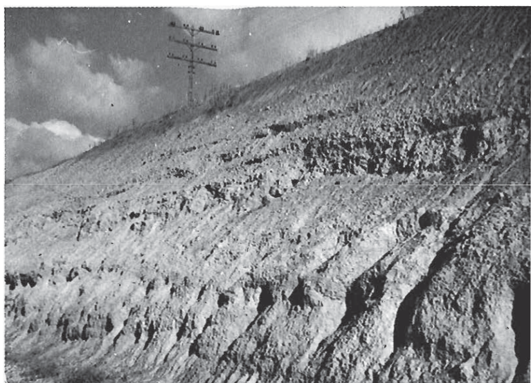
Fig. 27. Talud en margas y margocalizas (34 b 1 ) de la Cuesta del Agua
