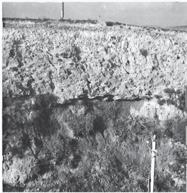
Fig. 9. Surgencias de aguas a media ladera en el contacto arenisca-marga del grupo 33 b, cerca de Lerma
