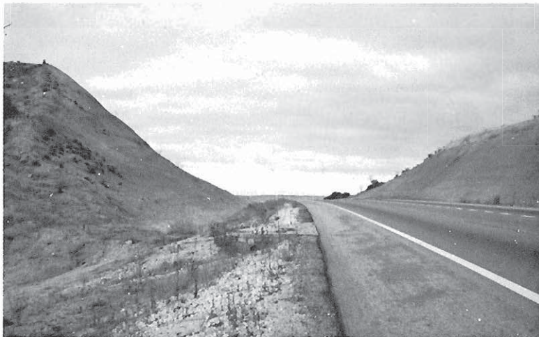
Fig. 6. Talud en margas rojas nodulosas al norte de Oquillas
