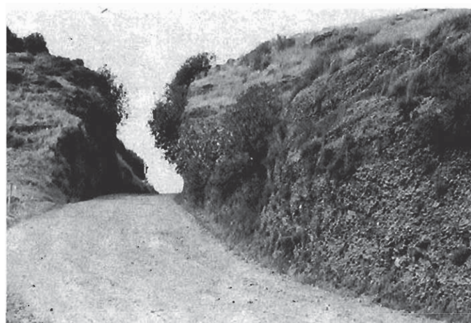
Conglomerados poco cementados. (7a)(Dc-2). Este de Montoro. 903-3
