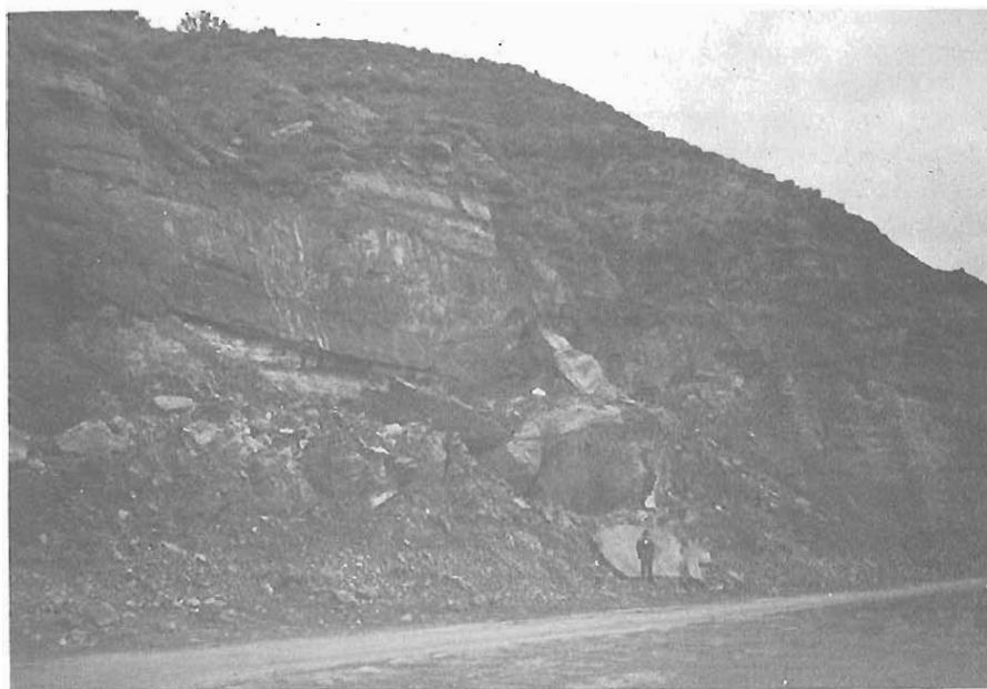
Fig. 10. Desprendimiento de margas areniscosas del Norte de Frega.
