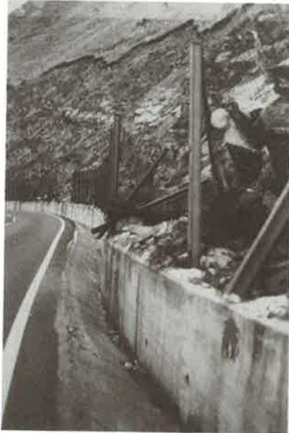
Foto 6.1. Pantalla metálica estática
