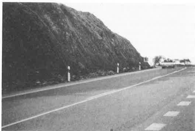
Foto 3.4. Malla adosada al talud
