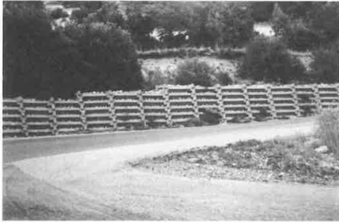
Foto 3.11. Muro de jaulas de hormigón
