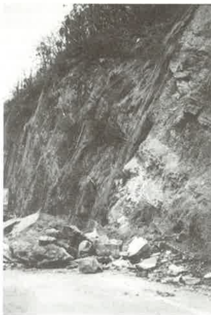
Foto 2.1. Desprendimiento ocurrido el pasado año. Carretera N-611, P.K. 178. Las Caldas de Besaya. Cantabria.
