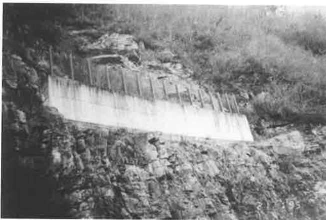
Foto 4.1. Pantalla estática sobre muro de hormigón
