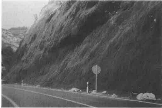
Foto 3.1. Aspecto de un talud hidrosechado
