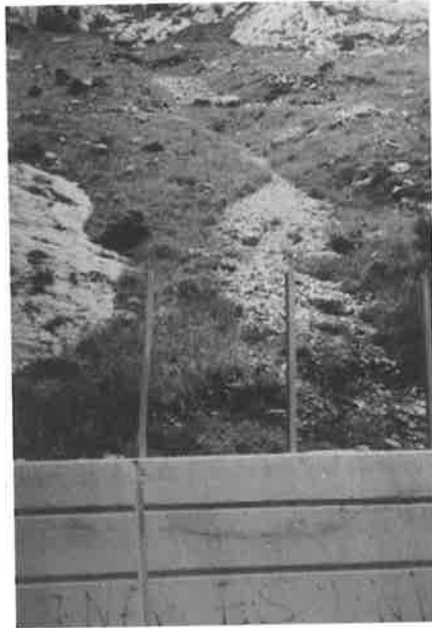
Foto 6.4. Aspecto de una pantalla rígida sobre muro, dos años después de su construcción
