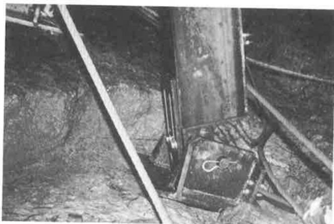
Foto 7.14. Detalle de la parte inferior del poste
