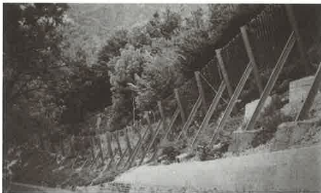
Foto 6.8. Pantalla de red cables con grapas
