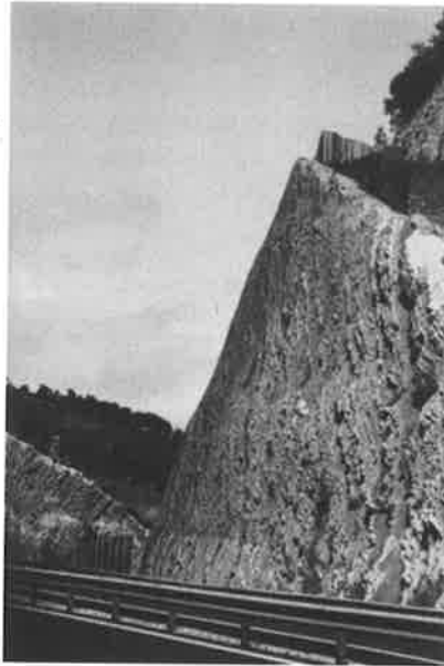
Foto 4.4. Solución de combinación de malla adosada con pantalla en el pie y la coronación del talud
