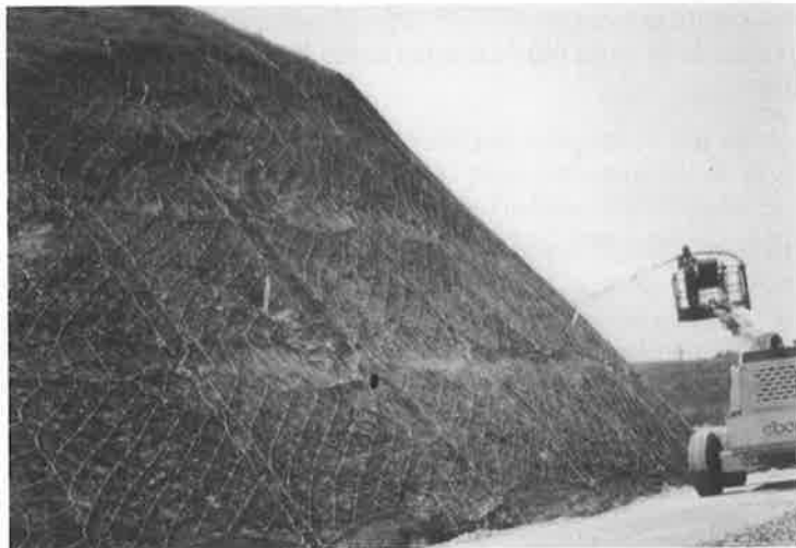
Foto 3.14. Montaje del pentifix
