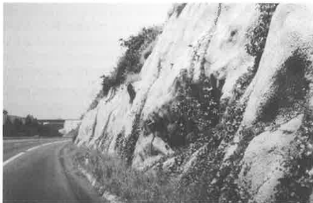
Foto 3.7. Solución de gunitado de color verde y con vegetación, para mejorar el aspecto del talud
