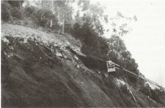
Foto 3.13. Aplicación del Guniverd
