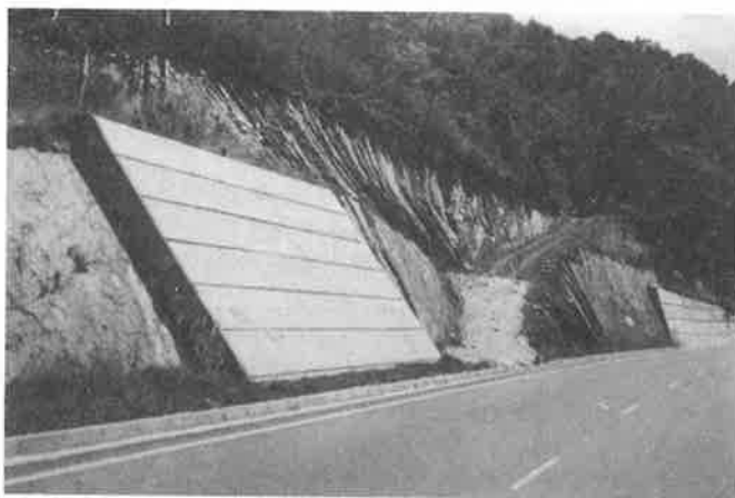
Foto 3.8. Muros de recalce de hormigón in situ
