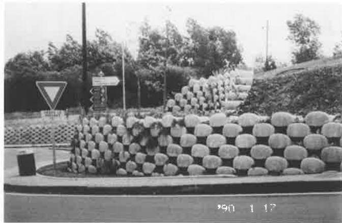
Foto 3.12. Muros de jardinera
