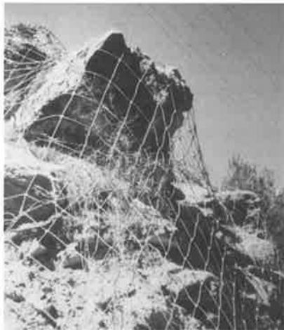
Foto 3.5. Malla de cables adosada al talud
