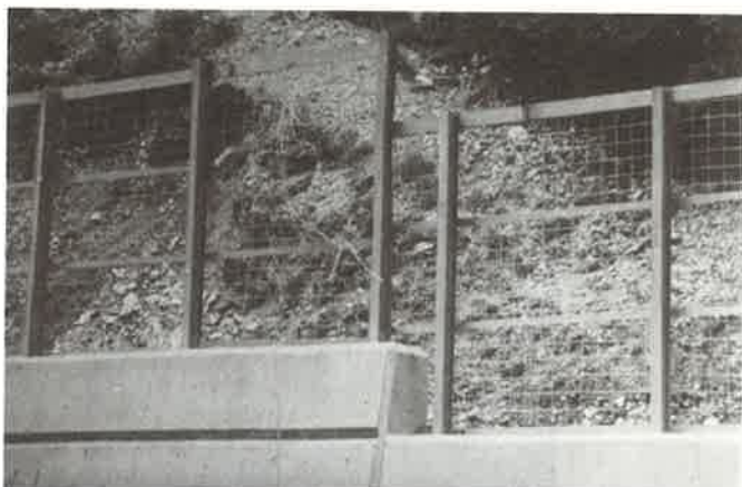
Foto 6.3. Detalle del fallo de una pantalla rígida con malla electrosoldada
