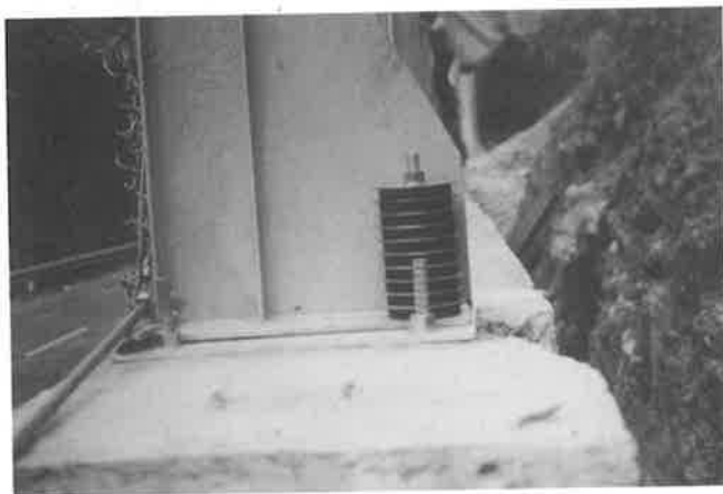
Foto 7.12. Detalle de la zona inferior del poste
