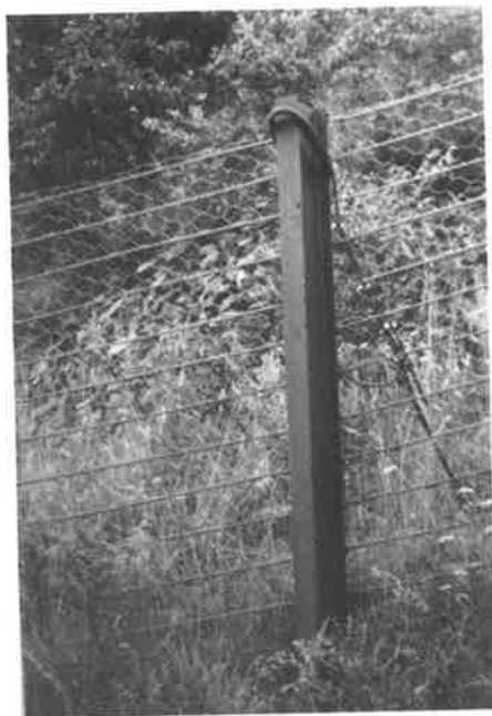
Foto 6.6. Pantalla de perfiles de acero y alambre de triple torsión, reforzada con cables
