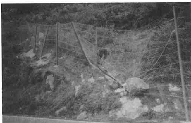
Foto 6.9. Pantalla provisional. Autovía Santander-Bilbao
