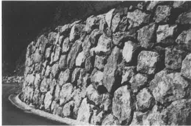
Foto 3.9. Muro de escollera
