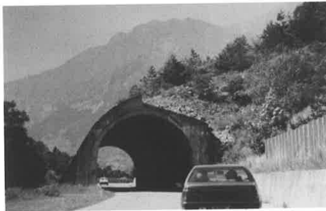
Foto 4.2. Semitúnel de protección contra la caída de rocas. Piamonte, Italia
