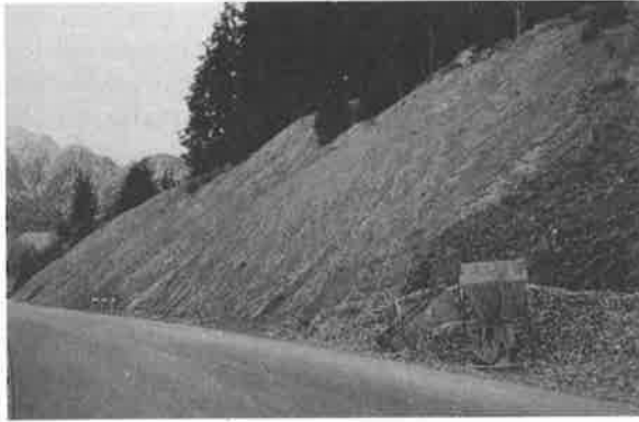
Foto 3.15. Primeros pasos para el montaje del sistema Krismer
