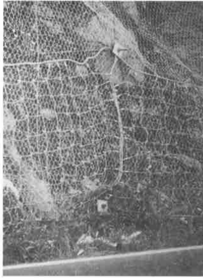
Foto 3.3. Detalle de la bolsa de cables inferior
