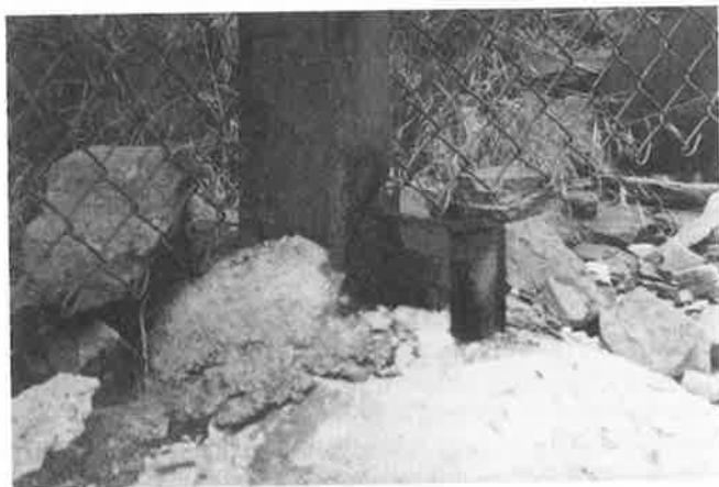
Foto 6.5. Reparación de un poste que falló a cortante
