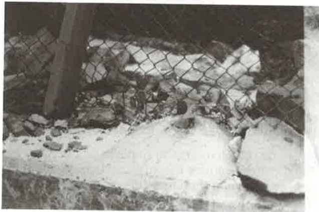
Foto 6.2. Detalle de rotura en el emplazamiento anterior
