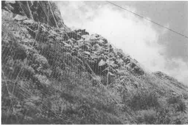
Foto 3.6. Malla de alambre de triple torsión reforzada con cables
