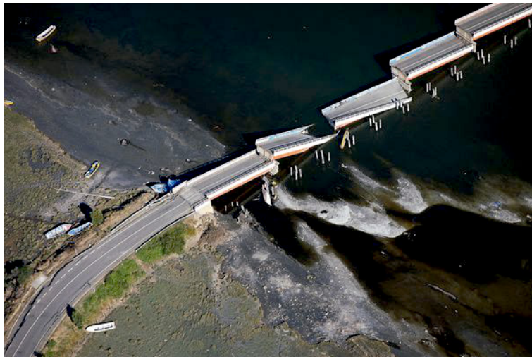
Figura 2 Colapso de varios tramos del tablero por pérdida de apoyo (Puente sobre el Río Tubul, Chile, terremoto de Concepción -27 de febrero de 2010-. Fotografía de Nicolás Piwonka, National Geographic)
