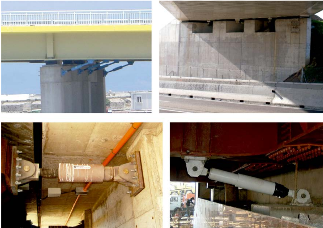
Figura 39 Ejemplos de amortiguadores viscosos dispuestos en puentes tanto en dirección longitudinal como transversal
