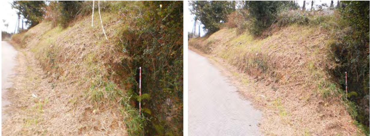
Figuras 41 y 42. Vistas generales del canal.
