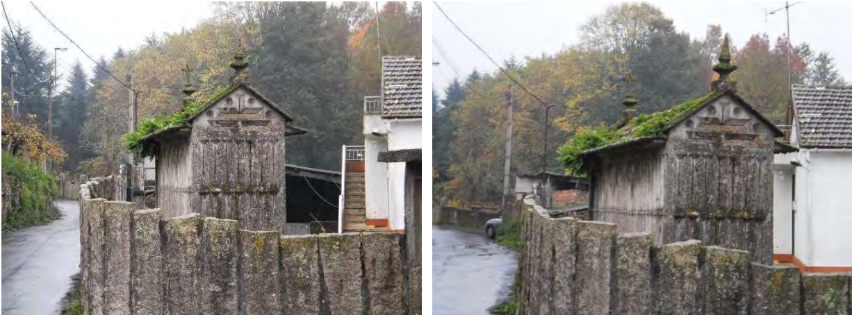
Figuras 56 y 57. Vistas generales del hórreo.
