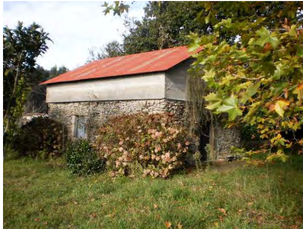
Figura 18. Vistas general del edificio.
