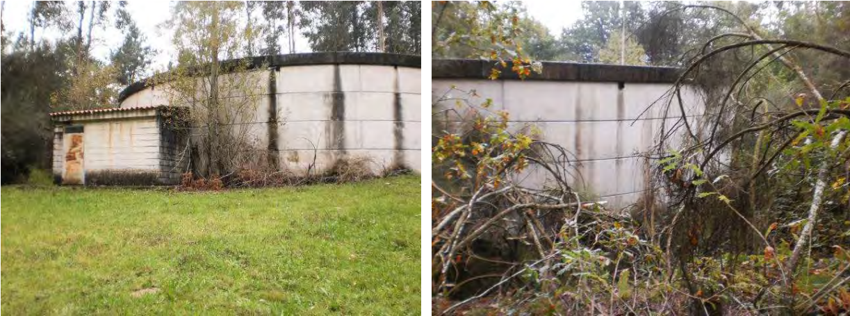
Figuras 36 y 37. Vista general y detalle de la zona donde se ubicó el depósito de agua.
