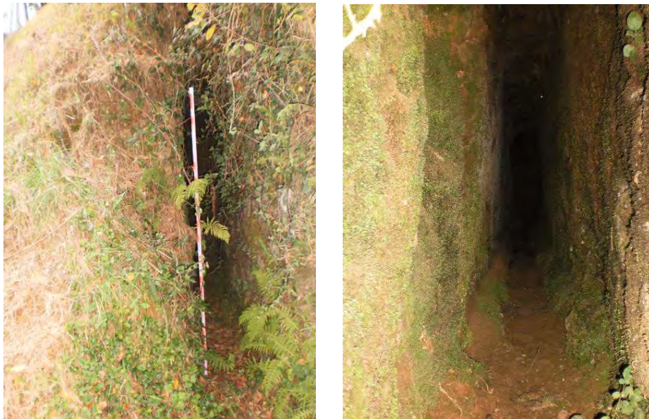
Figuras 43 y 44. Detalle de la boca conservada del canal y detalle del interior, con el canal excavado en la base.
