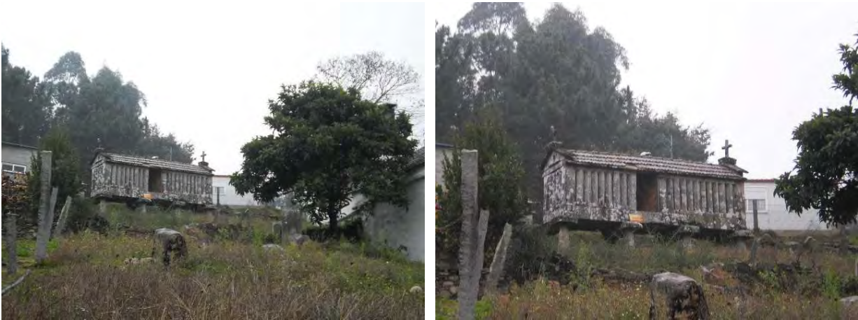
Figuras 54 y 55. Vistas generales del hórreo.
