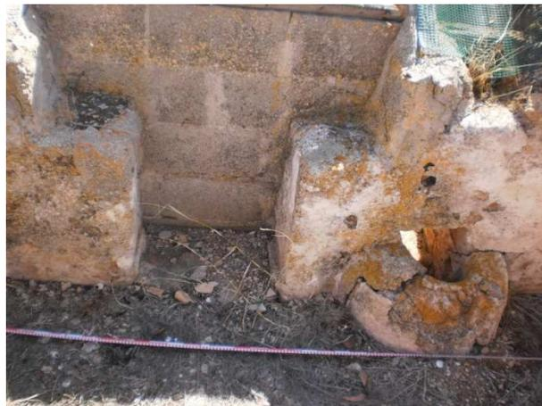
Figura 121. Acceso del brocal tapiado con ladrillos de hormigón.
