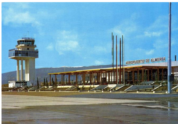
Ilustración 1.1.- Antigua fachada lado aire del Aeropuerto de Almería
