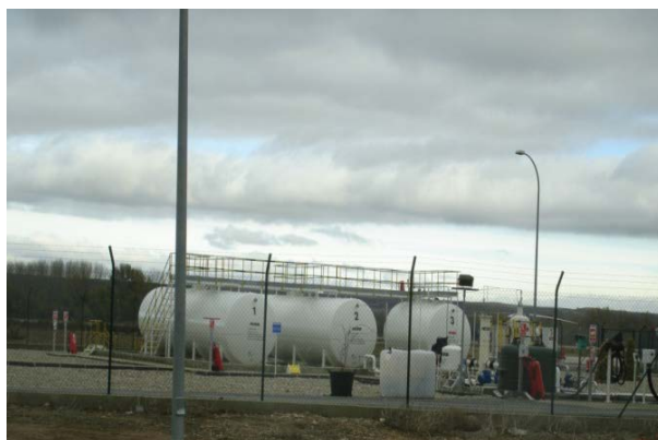
Ilustración 2.19.- Depósitos de combustible
