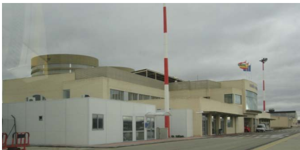
Ilustración 2.17.- Edificio de autoridades
