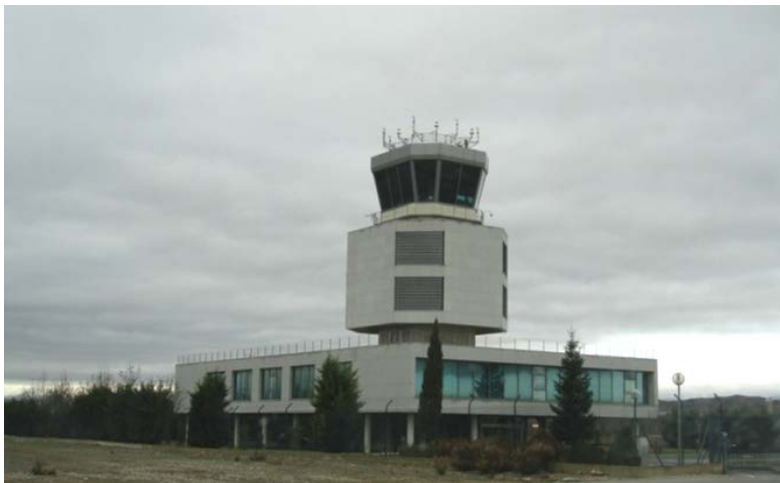
Ilustración 1.2.- Torre de control
