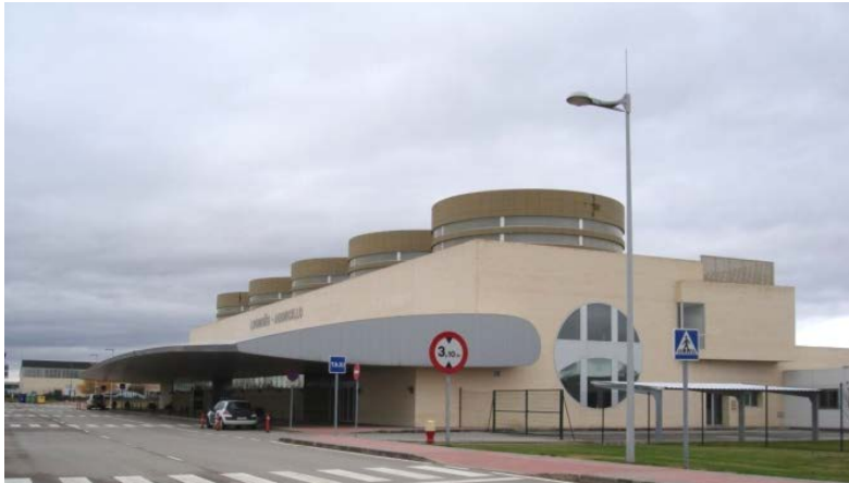
Ilustración 1.1.- Edificio Terminal de Pasajeros
