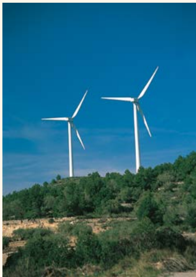
Parc eòlic del Perelló
