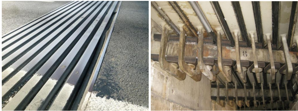
Figura 9. Vistas superior e inferior de las juntas modulares del Puente del Centenario.
