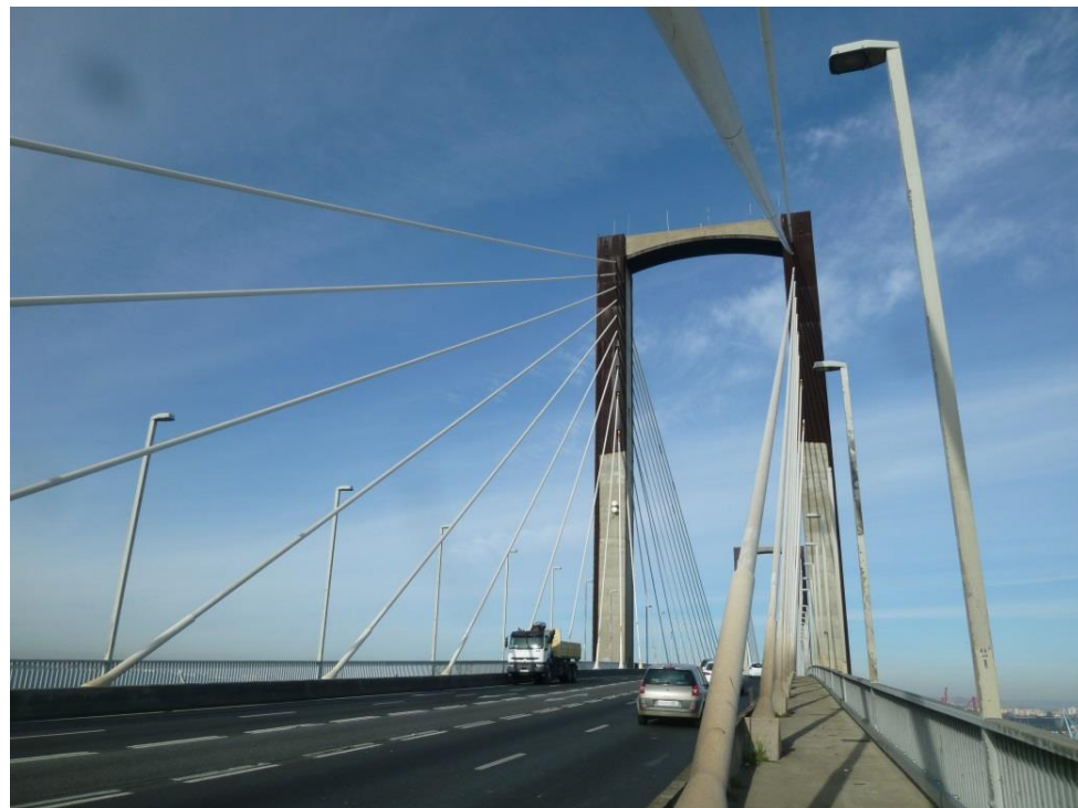
Figura 6. Vista de la P14 y de su atirantamiento desde la plataforma en el vano 13.
