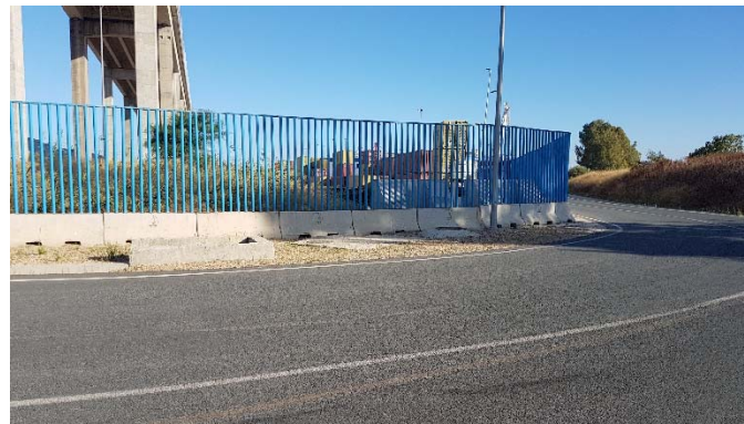
Cerramiento en muelle de contenedores
