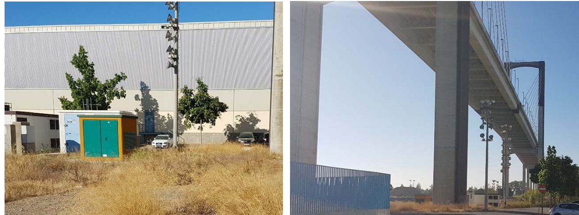
Afección n°3. CCMF/03
