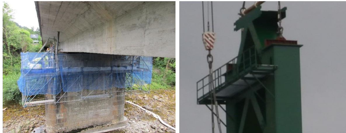
Figura 42. Detalle de distintas plataformas de trabajo colgadas/ancladas.
