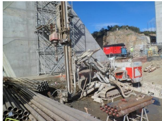
Figura 52. Maquinaria de micropilotes
