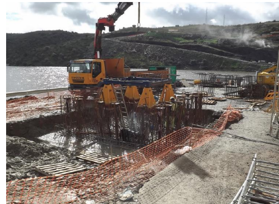
Figura 52. Armado de encepado.
