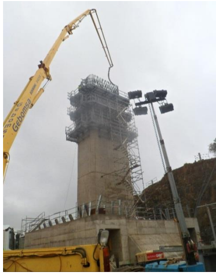
Figura 37. Hormigonado con autobomba
