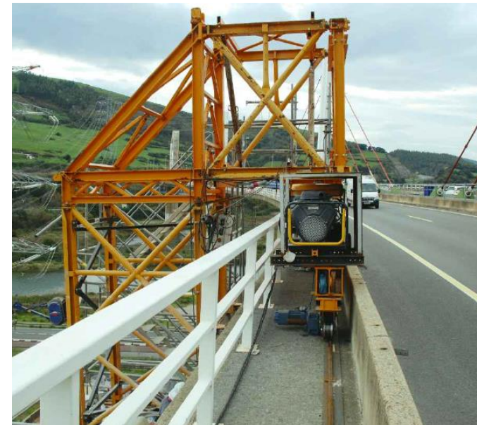
Figura 74. Sistema de guía en la zona de acera para desplazamiento del carro.
