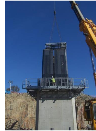
Figura 57. Detalle de plataforma de trabajo en altura anclada a la trepa anteriormente ejecutada y colocación de encofrado interior.
