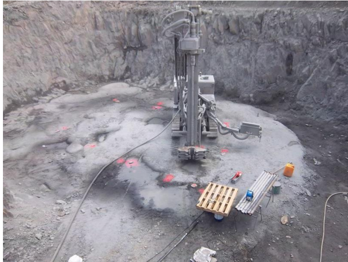
Figura 22. Ejemplo de maquinaria de tratamiento de inyecciones
