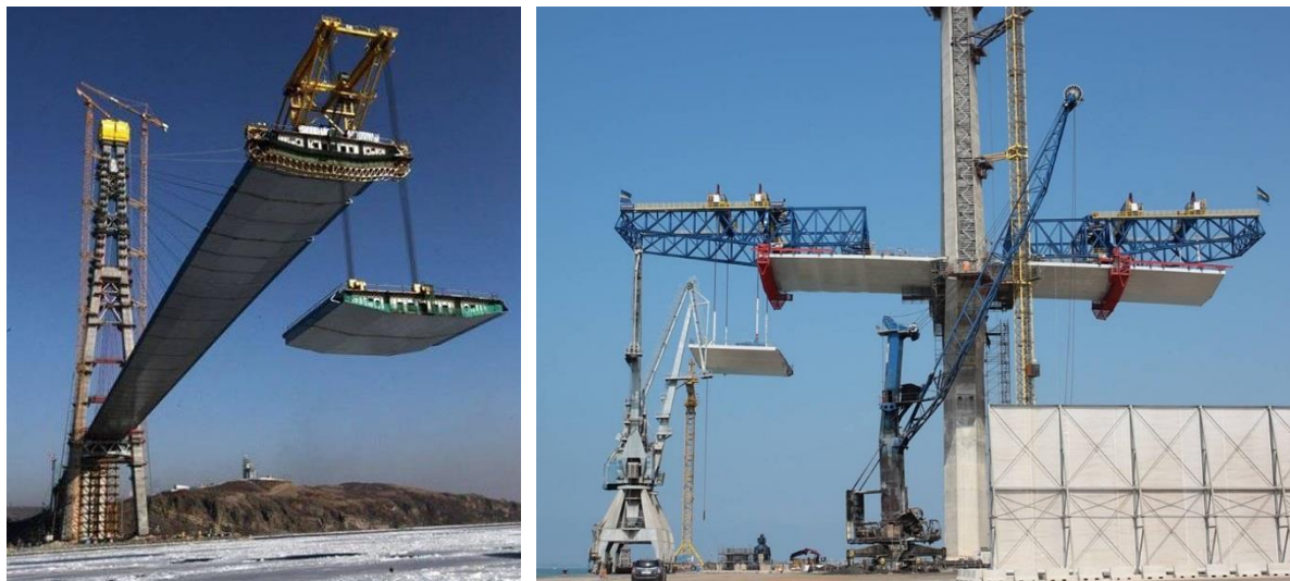
Figura 27. Sistemas de izado por cable de heavy lift
