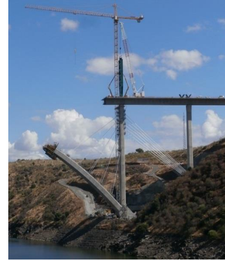
Figura 46. Vista general de grúa torre en la ejecución del Viaducto del Tajo en Cáceres.
