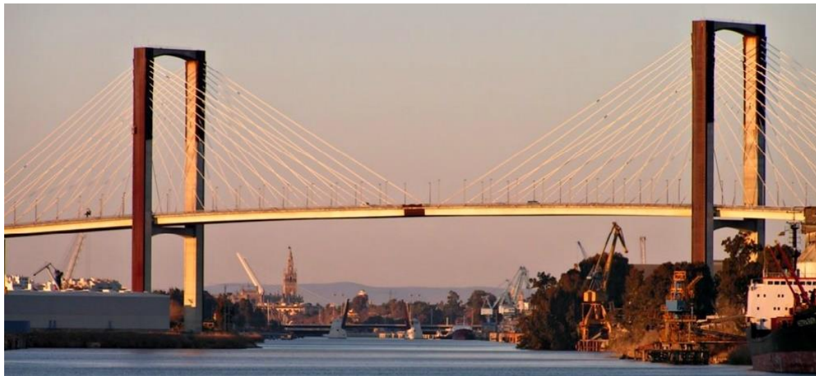
Figura 7. Vista general de las pilas principales (pilonos) del puente del Centenario
