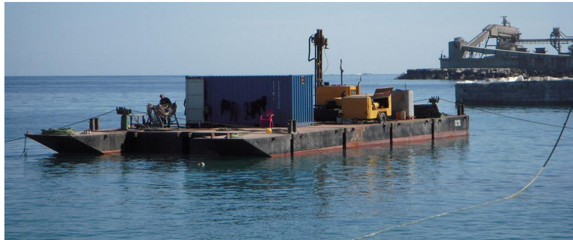
Figura 70. Pontona modular para transporte de la dovela.
