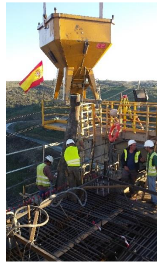
Figura 37. Hormigonado con cubilote para alturas grandes.
