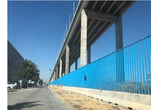
Figura 18. Vista del cerramiento existente junto al viario situado en la zona del ZAL
