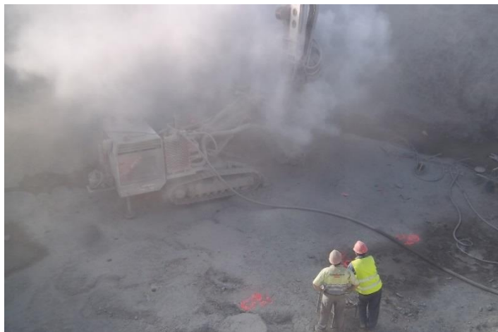
Figura 23. Polvo generado durante los trabajos de perforación.
