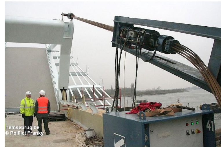
Figura 62. Ejemplo de sistema de atirantamiento provisional.
