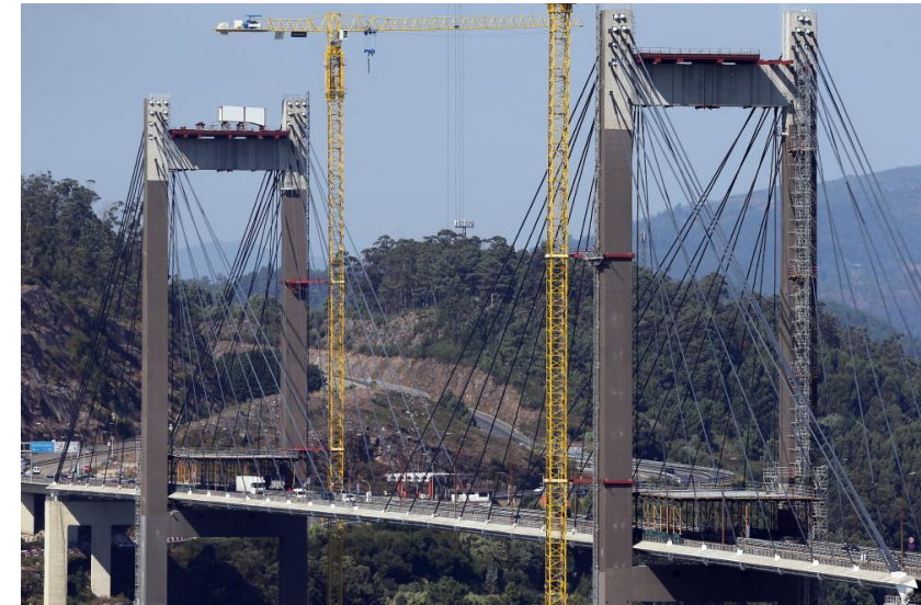
Figura 47. Grúa torre arriestrada para la ampliación del puente de Rande.
