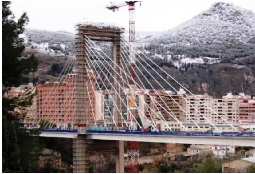
Figura 48. Grúa torre autoestable para la reparación del puente de Fernando Reig (Alcoy)
