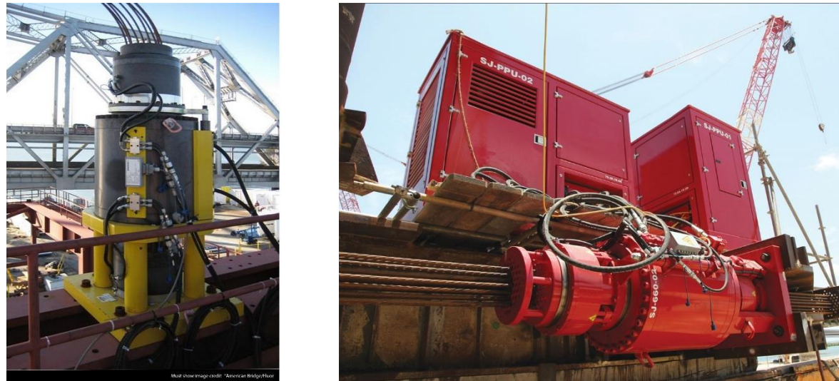
Figura 65. Ejemplos de gatos de cable de izado
